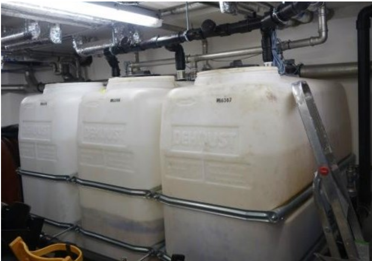
Tankanlægget i kælderen
