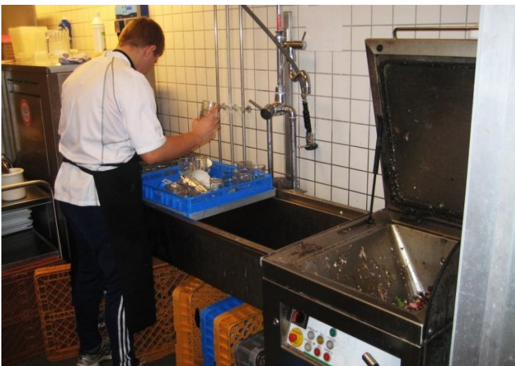
Køkkenkværnen er placeret i opvasken, hvor afskrabet kan gå i. På den måde reduceres rørføringerne på den begrænsede plads i køkkenet. Køkkenkværnen ses til højre i billedet
