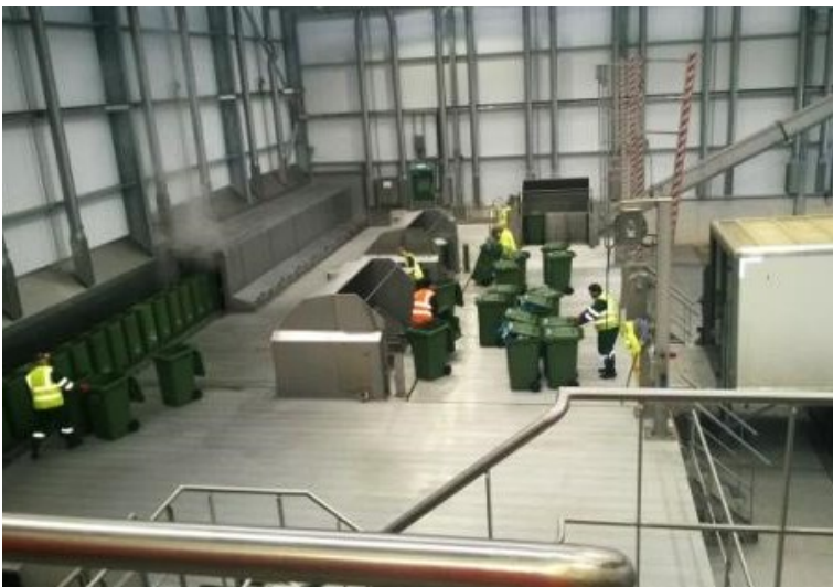
System i Doncaster, UK med sortering og genanvendelse af madaffald fra servicesektoren
