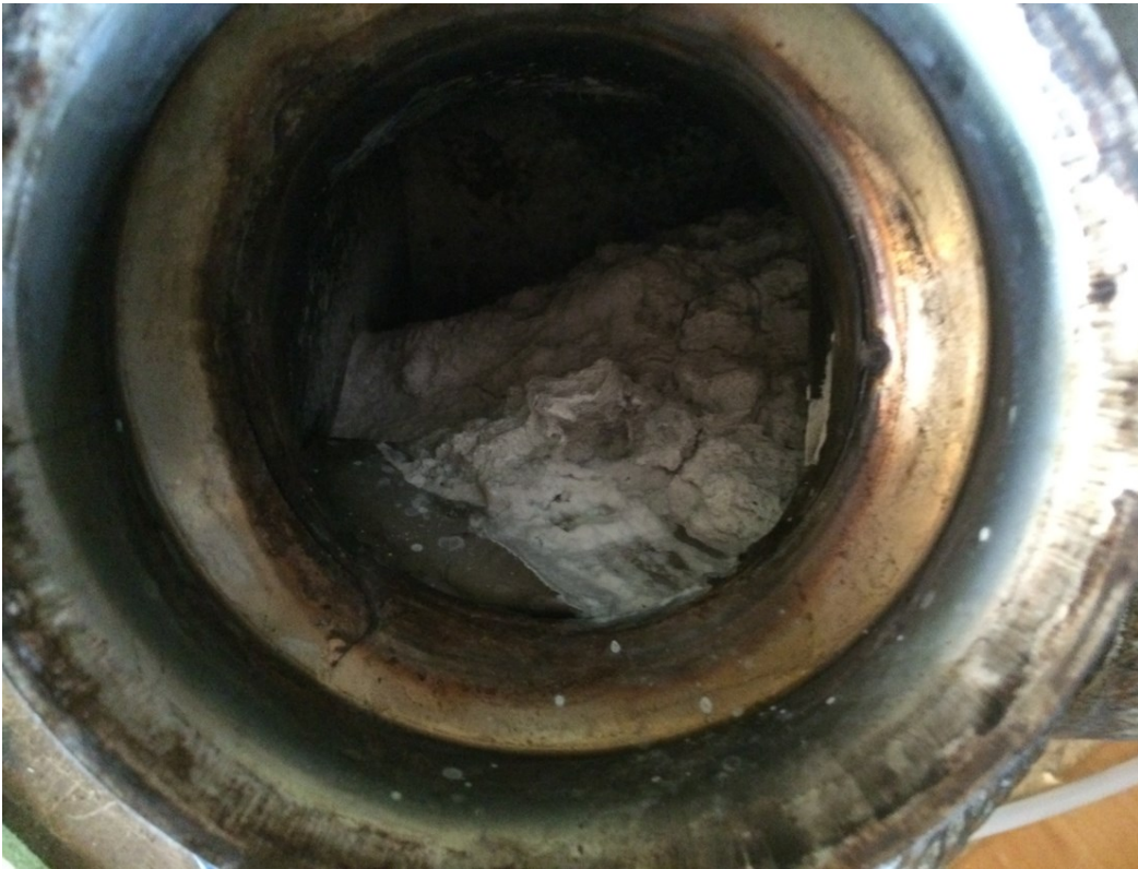
FIGUR 33 UDSTØDNINGSRØR FRA BUS10-EUROV-SCR UMIDDELBART EFTER ORIGINAL MONTERET INDSPRØJTNINGSDYSSE. SYSTEMET VAR FEJLBEHÆFTET OG UREA-DOSERINGEN VAR MEGET TILFÆLDIG. UREA KRYSTALLER DANNES OMKRING DEN ORIGINALE DYSSE OG VIL MED TIDEN TILSTOPPE GASGENNEMSTRØMNINGEN.
