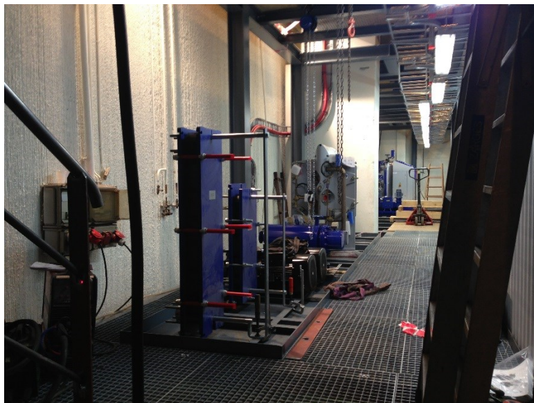
Figur 16: Pladevekslere til køling af motoren og opvarmning af fjernvarme.
