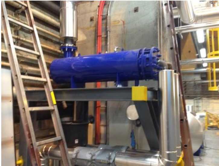
Figur 17: Kondensator til generering af fjernvarme ved hjælp af damp fra udstødningskedlen.
