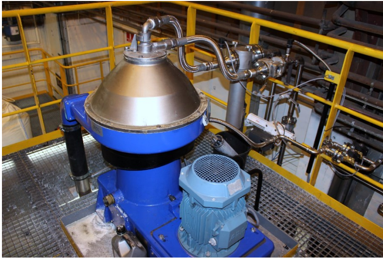
Figur 26: Højhastigheds separator (SWPX 407) for rensning af scrubbervand. Sod slam indeholdende ca. 10% (w/w) vand skydes fra separatoren og ned i en tank placeret under denne.
