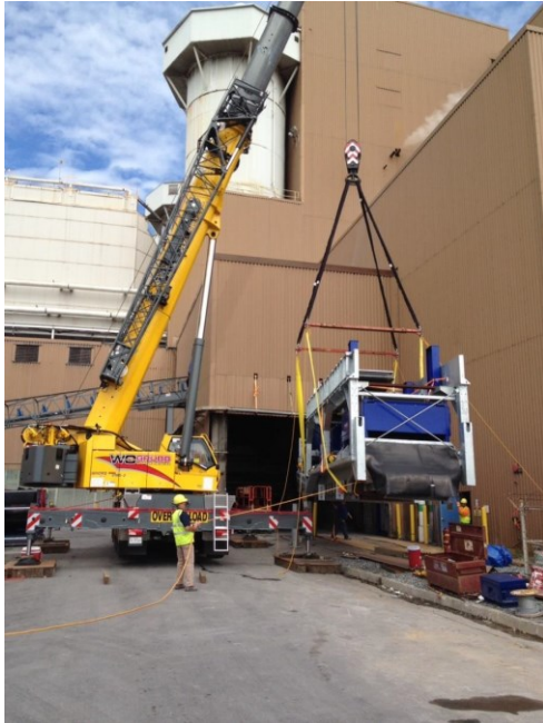
Figur 19: Håndtering af forsorteringsanlæg med mobilkran. Kilde: Meldgaard US Inc.
