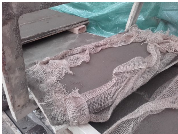
Figur 43: Lerplade med væv på oversiden
