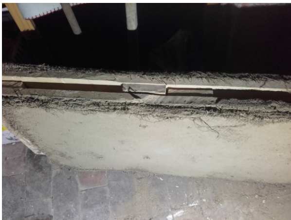
Figur 47: Lerplade med væv på oversiden
