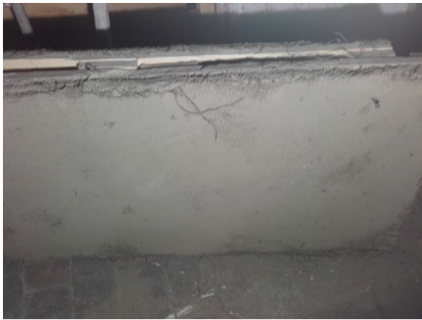
Figur 46: Lerplade med væv på oversiden
