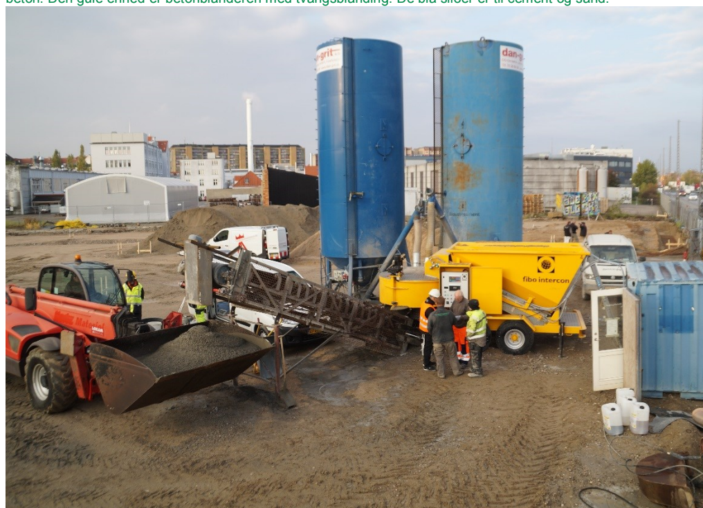
Figur 9 Foto af betonanlæg på Prags Boulevard med udstøbning af fundamenter af beton med tilslag af nedknust beton. Den gule enhed er betonblanderen med tvangsblending. De blå siloer er til cement og sand.
