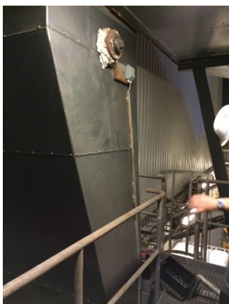
FIGUR 20. PUNKT H INDEN PRØVEUDTAGNINGSDYSTYR RIGGES TIL
