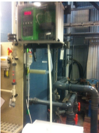
FIGUR 17. AUTOMATISERET UDTAG AF RØGGASKONDENSAT
