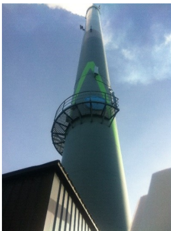
FIGUR 18. RENOSYDS SKORSTEN MED GALLERIET HVORFRA PRØVEUDTAGNINGEN BLEV FORETAGET.
