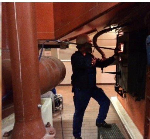
FIGUR 13. IN SITU SLAGGEUDTAGNING
