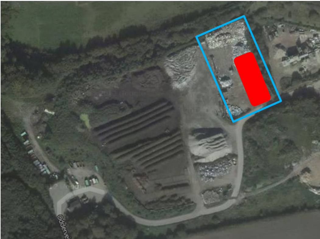
FIGUR 1. OVERSIGTSKORT OVER AFFALDSCENTER SKÅRUP VED SKANDERBORG. DEN RØDE AFGRÆNSNING VISER OPMAGASINERINGSOMRÅDET FOR DE 800 TONS IMPRÆGNERET TRÆAFFALD, OG DEN BLÅ LINJE VISER OMRÅDET FOR NEDDELINGEN OG DEN REPRÆSENTATIVE PRØVEUDTAGNING
