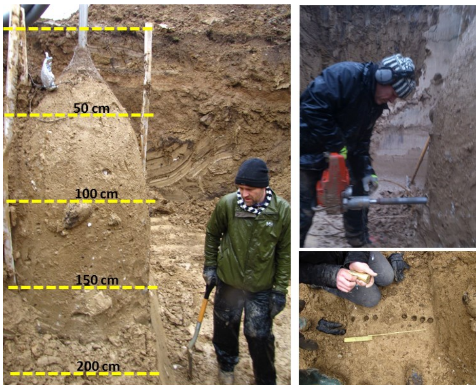
FIGUR 45: UDGRAVNING AF DEN FROSNE BLOK RUNDT OM FRYSEBORINGEN. BE-MÆRK BLOKKENS FORM OG DE FASTFROSNE INJEKTIONSRØR. DIAMETEREN ER 120 CM OG JORDPRØVER BLEV UDTAGET I MESSINGRØR I DEN UFROSNE ZONE OG SOM BOREKERNE I DEN FROSNE DEL. ARBEJDET VAR SÆRDELES VANSKELIGT AT UDFØRE PÅ GRUND AF REGN.
