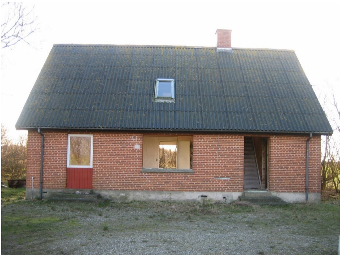
Figur 2. Foto af forsøgsbygningen. Bollerupvej 75 - før retablering
