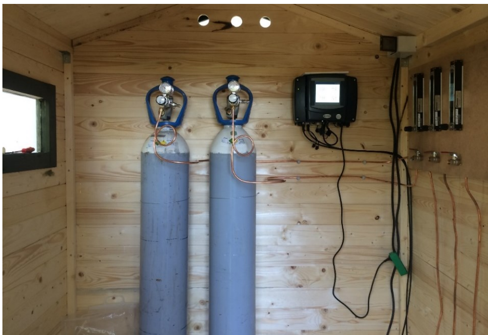
Foto 3.3 Iltinjektionsanlæg med iltflasker og manifold.
