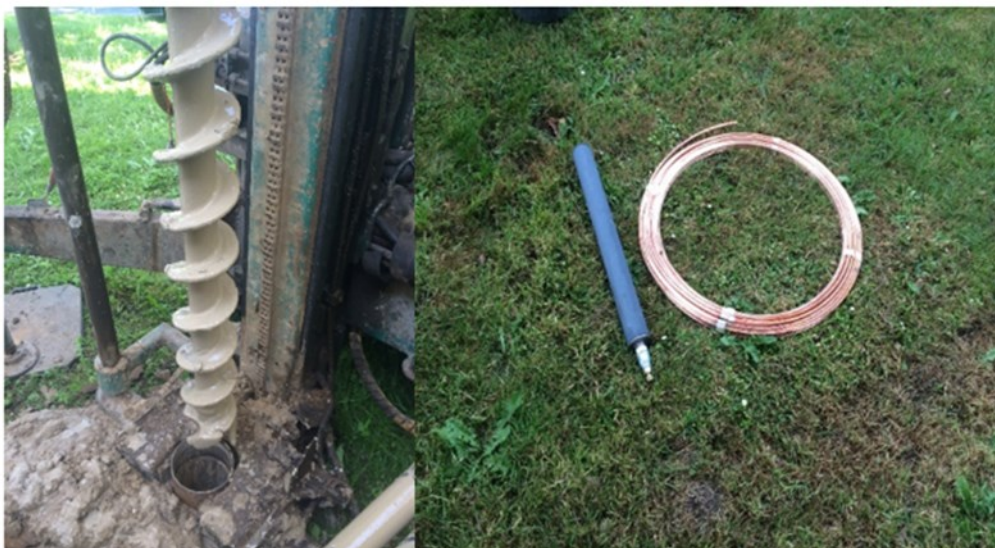
Foto 3.1 Fores 6" snegleboring (tv) og diffusere (th)
