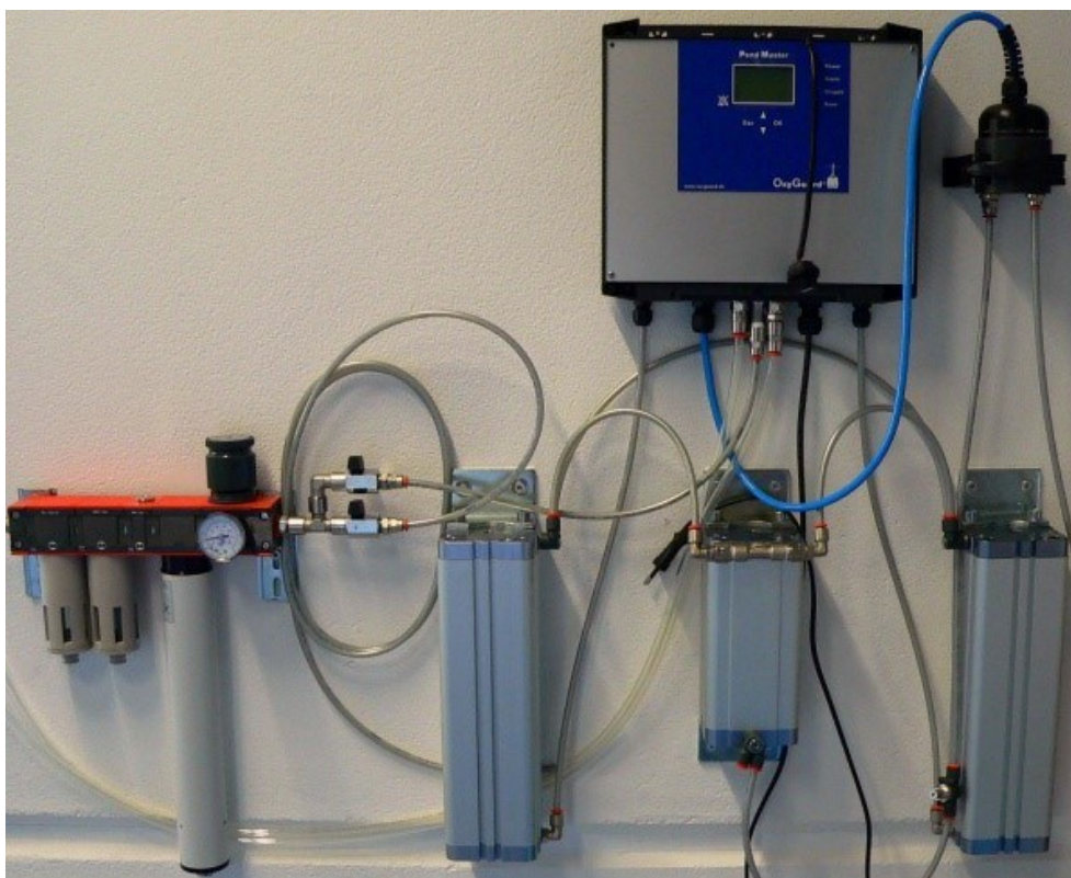
Figur 2 PSA Iltgenerator etableret i laboratoriet
