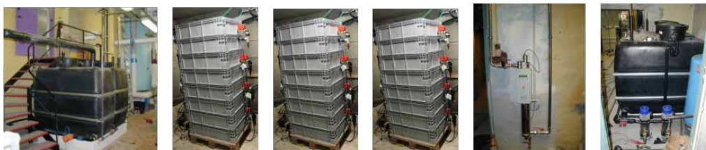
Figur 11.2: Foto-illustration af system til rensning af gråvand på Nordhavsgården vha. tre DPF-Gråvandsenheder som erstatning for nuværende system bestående af RBC, lameludskillere og sandfilter.
