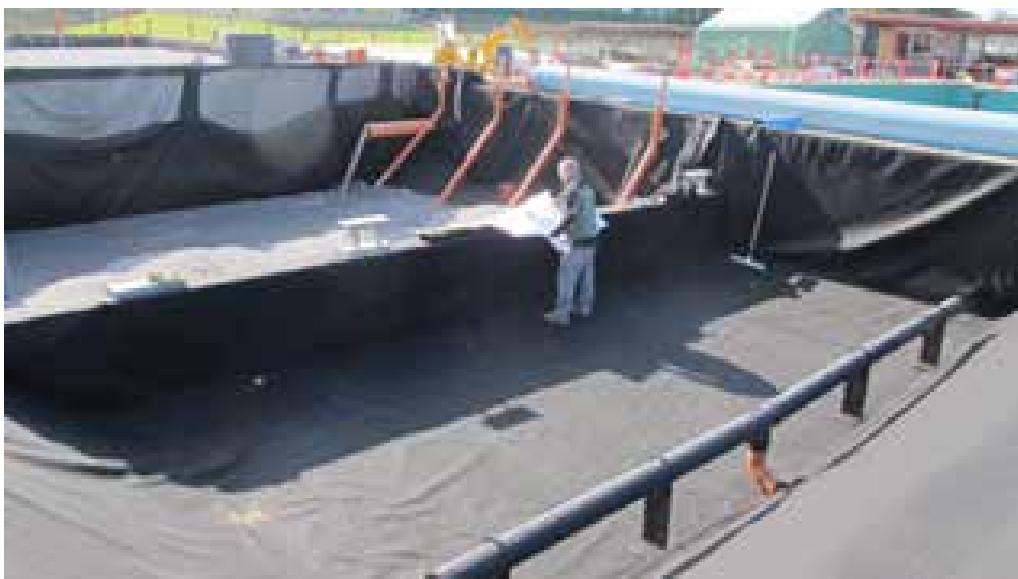
Figur 11.4: Det biologiske renseanlæg ved RVF- Øverst ses alle tre filtre bestående af 1) "aquakulturfilteret" (i midten), 2) "det hydrobotaniske filter" (forrest) og 3) "det tekniske filter" (bagerst). Foto: Lars Juncker. Nederst ses filter 1 (substrat placeret) og filter 2 under konstruktion. Foto: Per Bjerager.
