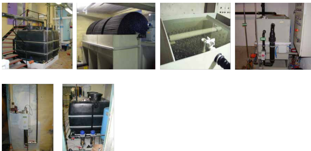
Figur 11.1b. Foto-illustration af behandlingssystem. Øverst fra venstre: Primære sedimentationstanke, de tre roterende møllehjul, lameludskiller, sandfilter (ikke vist i hverken Figur 9a), UV-behandling og rentvandstanke. Fra Miljøstyrelsen, 2004.
