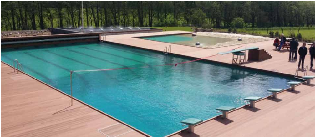
Figur 11.3: Ruds Vedby Friluftsbad efter renovering. I forgrunden det store bassin, bagerst til højre børnebassinet med sand i den ene del. I baggrunden skimtes det biologiske renseanlæg. De samlede vandoverflader er ca. 700 m 2 og det samlede vandvolumen ca. 860 m 3 . Foto: Lars Juncker.
