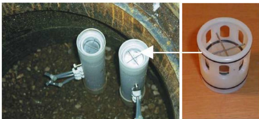
Figur 16. Principskitse for etablering af afværgesystem samt billede af in-line én-vejs ventil /2/
