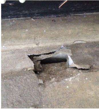
FIGURE 10 PRØVETAGNING AF BETONKLODS PÅ NORDGÅRDSKOLEN
