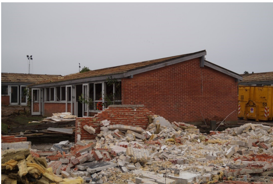
Figur 4.1 Bygninger, som nedrives, forsøg med modificeret grab.
