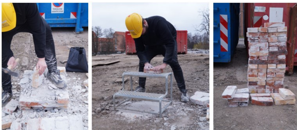
Figur 2.6. Håndrensning af mursten startende til venstre med udtagning og grovrensning af sten efterfulgt med rensning på trapperist og oplægning. Foran stablen af sten ses sten med forskellig brænding og størrelse.
