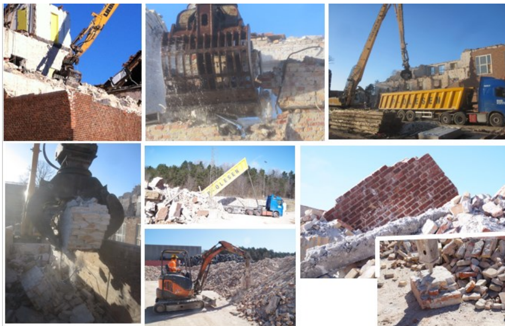
Figur 2.5 Nedrivning med langarm, læsning på Bispebjerg og aflæsning hos Gamle Mursten i Hedehusene. Nedrivning og aflevering af store brokker nødvendiggør efterknusning på pladsen i Hedehusene.
