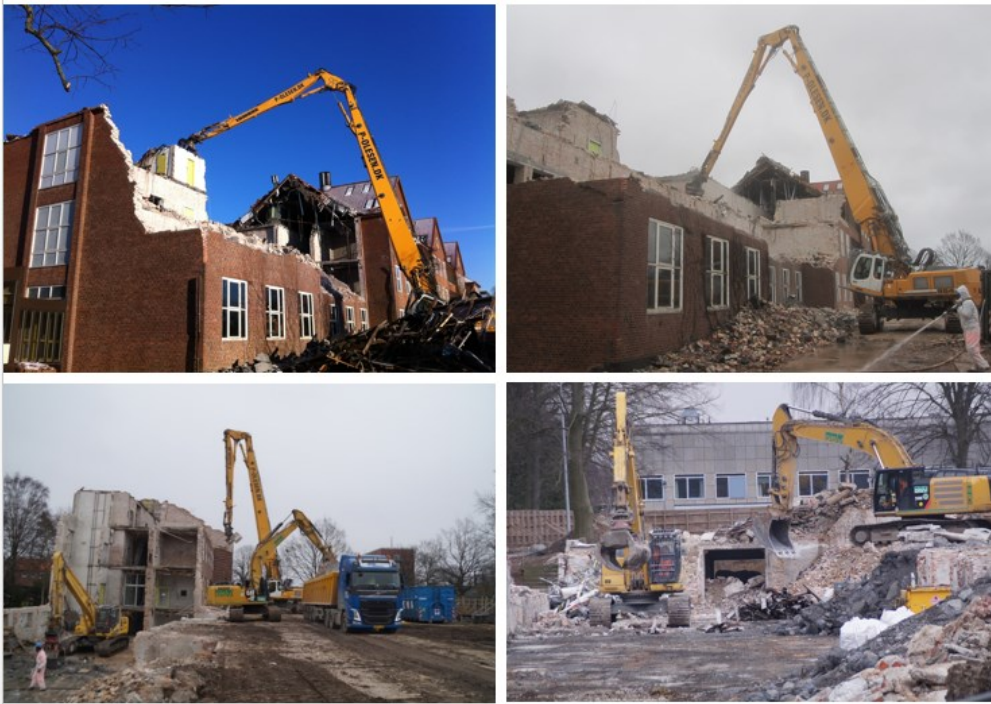
Figur 2.3 Forskellige stadier af nedrivning af rådus, bygning 13, fra start i januar til afslutning i april 2016. Langarm og gravemaskine arbejder med nedrivning af rådus og læsning af brokker på 7-akslet køretøj. Gravemaskine arbejder i kælder med nedrivning og sortering af betonbrokker. Arbejdsmandskab er iført sikkerhedsudstyr på grund af de blyforurenede brokker.
