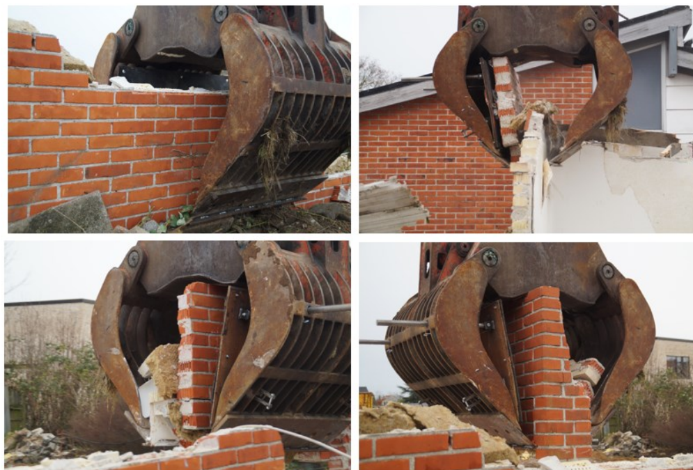
Figur 4.3 Modificeret sorteringsgrab i funktion.
