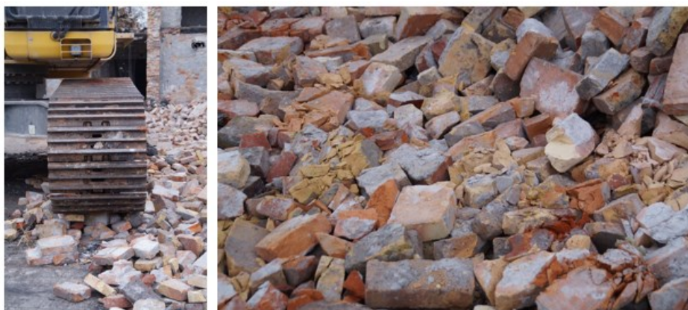
Figur 2.7. Kørsel med gravemaskine i brokker. Det ses tydeligt, at det øverste lag sten er knust.
