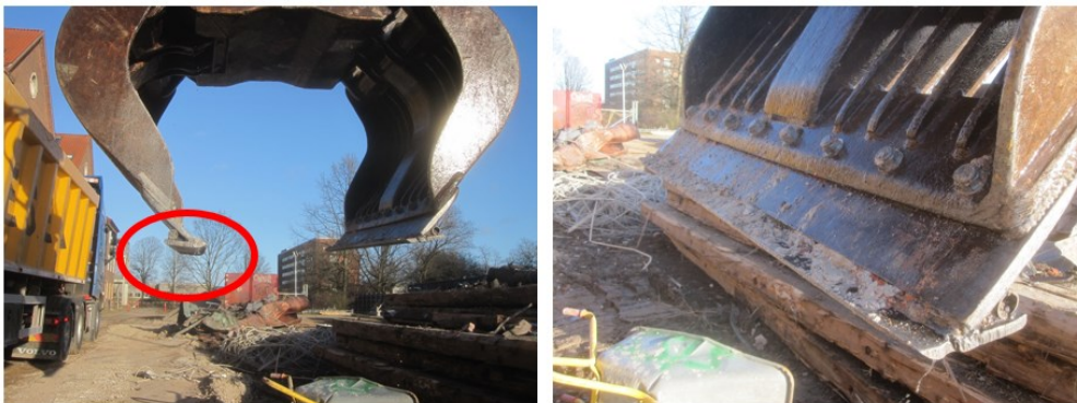
Figur 2.4 Modifieret sorteringsgab med påsvejt ekstra skær. Det normale skær påvirker murværket med en skråtstillet kraftpåvirkning, som skader stenene i brudzonen. Det modificerede skær giver bevirker horisontal virkning i murværkets fuger og dermed mindre skade på murstenene i brudzonen. Derved kan man frigøre større sammenhængende mængder murværk.
