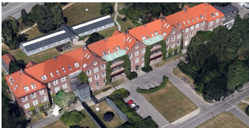
Figur 2.2. Foto af Bygning 13, Bispebjerg Hospital, (Foto Google Earth)
