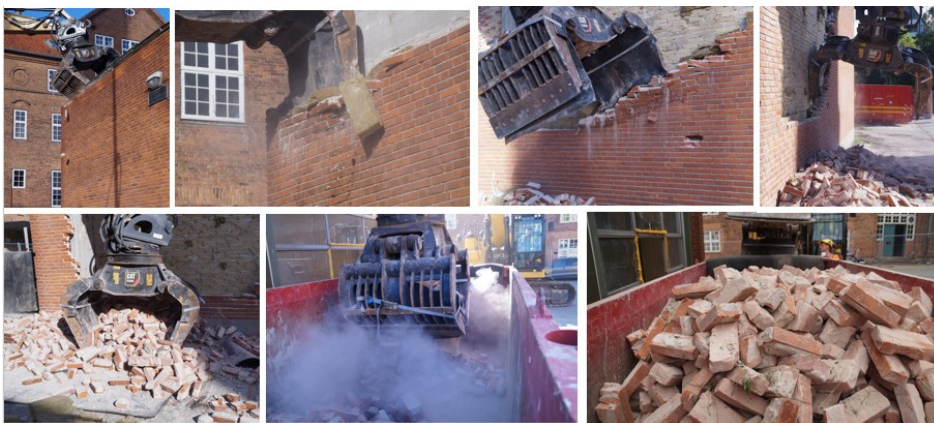
Figur 3.2 Skånsom nedrivning af sydfacade på garagebygning,
