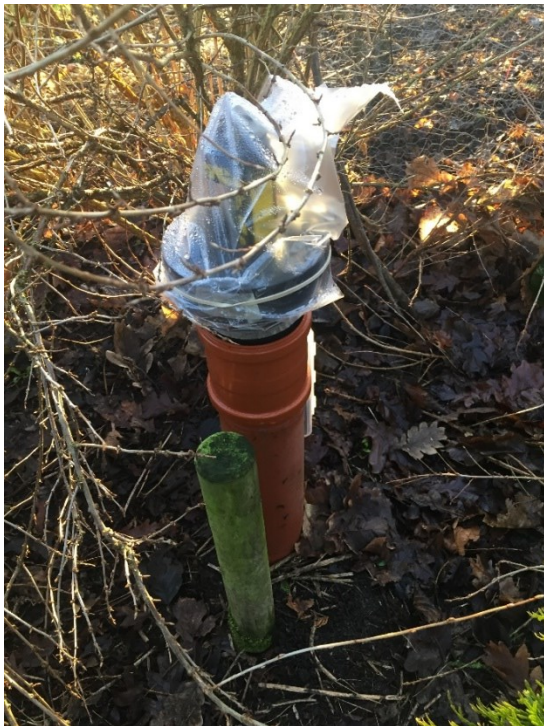
Figur 20. Udluftning fra septiktank med Hybrid-minifilter og gassensor monteret.
