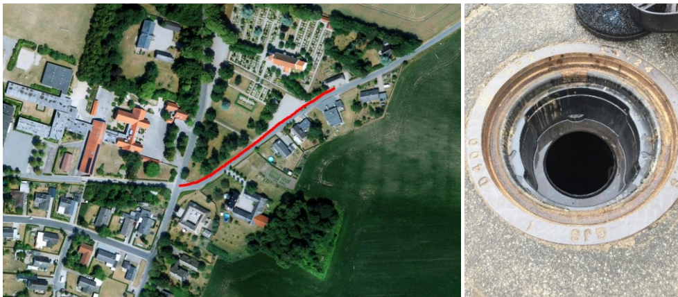
Figur 17. Luftfoto af målelokalitet ved Krogsbølle på Nordfyn (t.v.). Den undersøgte ledningsstækning er angivet med rød. Kloakbrønd fra Krogsbølle med hybridfilterindsats (t.h.).
