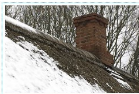
Nærbillede af Tang-Tørvene som mønstre på det stråtekte hus i Feldballe ved workshoppen. Mønstrene har fået en lys hvidliggrøn nuance, som også kendes fra Læsøtangtagene, og matcher stråtaget nydeligt.
