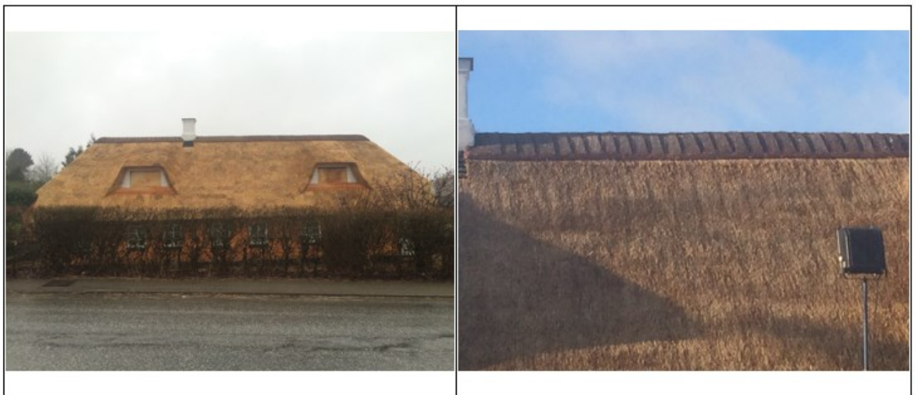
Mønning med tang-tørv på Fyn, ved Højfyns Tække- og isoleringsservice ved Tonny og Allan Nielsen. Foto: Allan Nielsen.
