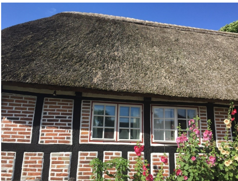
Tagmønning efter et år. Sommer 2016. Farveændringen til grålig ses tydeligt. Foto: Bodil E. Pallesen; Teknologisk Institut, AgroTech
