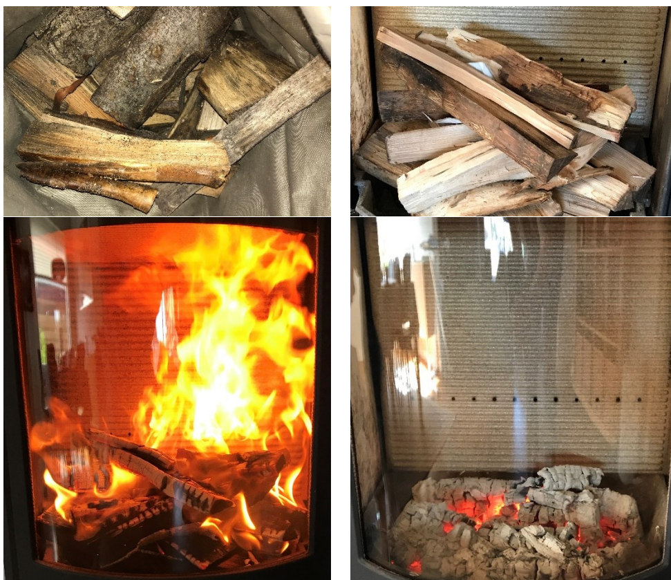
Hus nr. 9.2 Efter renovering: Brænde, optænding, forbrænding og gløder gennem ren glaslåge
