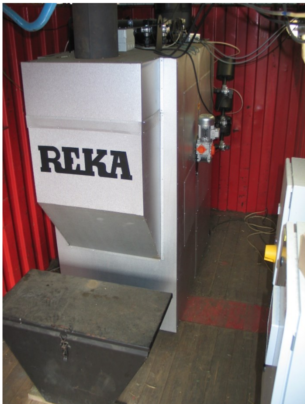
Figur 4. Elektrofilter til halmfyrede kedler i ydelsesintervallet 80 – 200 kW. Filtret er med 5 kanaler og opsamlerskiver med en diameter på 900 mm.
