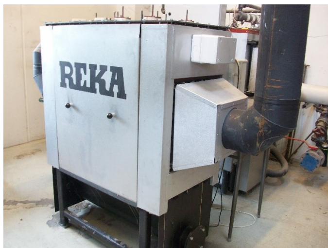
Figur 3. Elektrofilter til pille og flis fyr i ydelsesintervallet 20 – 80 kW. Filtret er med 4 kanaler og opsamlerskiver med en diameter på 600 mm.
