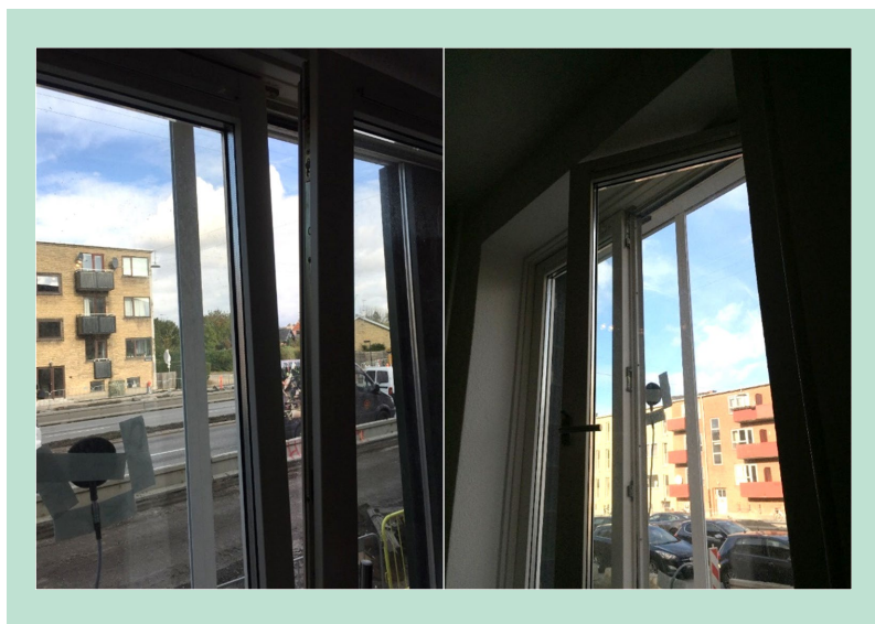
FIGUR 12. Illustration af vinduernes åbninger under lydmålingerne, til venstre vinduet i kip-position og til højre i drejet position.
