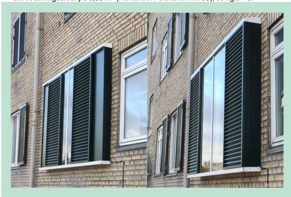
FIGUR 10. Foto af prototyperne på de to typer nyudviklede lydskodder, dels med samlet spalteåbningsareal på 0,14 m 2 (til venstre), dels 0,35 m 2 monteret (til højre). Det bemærkes, at billederne viser prototyperne. Det endelige design af de 42 lydskodder, der efterfølgende blev monteret, er vist på figur 13, Figur 14 og Figur 18.
