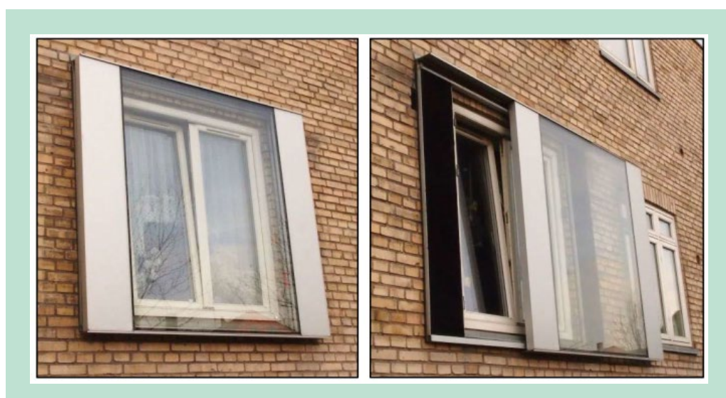
FIGUR 2. Fotos af lydskoddens udseende og funktion. På fotoet til venstre ses den lukkede lydskodde, til højre lydskodden kørt til siden og man kan bl.a. se det mørke lydabsorberende materiale, der bidrager til reduktion af støjen, når skodden er lukket. På begge fotos er det eksisterende side-bundhængte, indadgående vindue åbnet i ventilationsstilling. Kilde: Rasmussen B. (2015). Erfaringer med lydisolerede åbne vinduer i trafikstøjbelastede boligområder. SBI rapport 2015:08.
