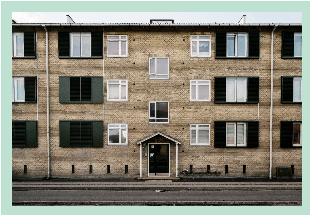
FIGUR 13. Facade med de nye lydskodder i den endelig udformning mod Folehaven.
