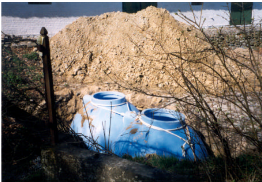
Figur 7.1 Nedgravning af lagertankene.
