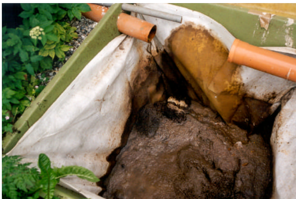
August 2001, hvor DS toiletet har været installeret i knap 4 måneder. Toiletets vandskyl er væsentlig større end skyllet i Eco-vip og materialeoverfladen virker ”slammet”.
