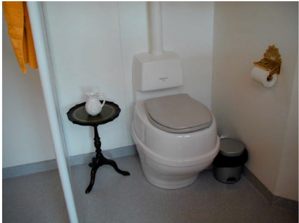
Figur 4.1 "Separett Villa", et lille batchsystem monteret over gulv
