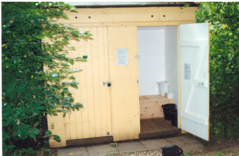
Figur 5.6 Komposttoilet ved Skelsnæs Pavillionen
