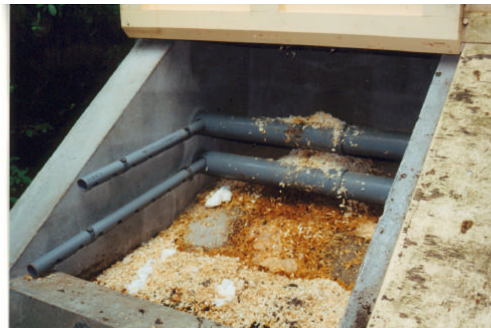
Figur 7.4 Opsamlings- og komposteringsrummet i komposttoiletet ved Skelssnæs
