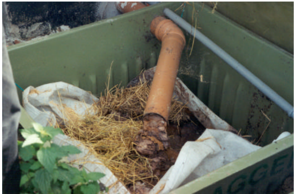
Filterposen er trukket skæv p.gr.a den dårlige ophængning
