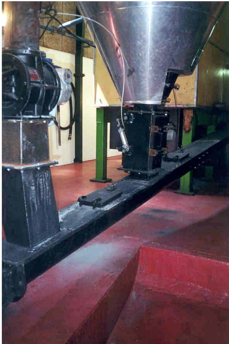
Figur 6.6. Fil ter- og cyklonaske blev udtaget for enden af denne askesnegl på Rødby Varmeværk.
