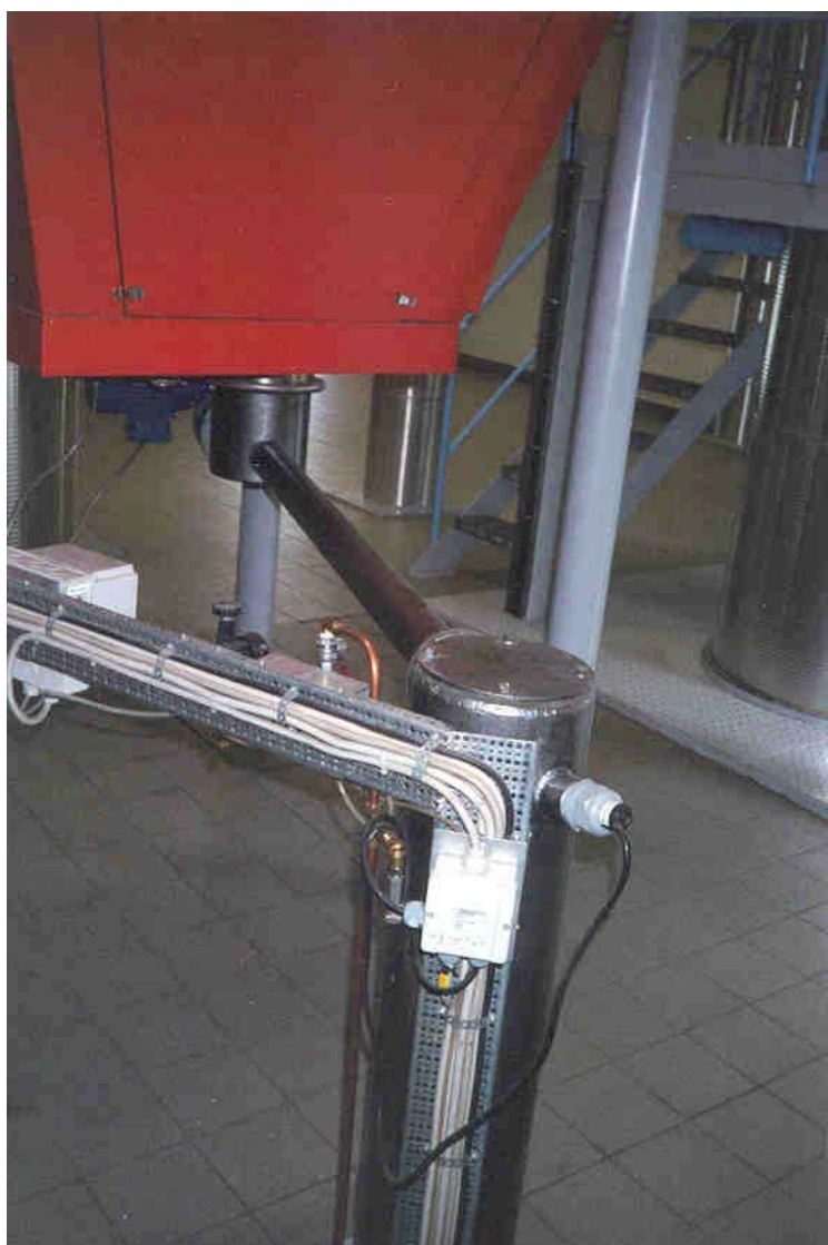
Figur 6.11. Cyklonasken blev udtaget i toppen af askefaldet på Græsted Fjernvarme.
