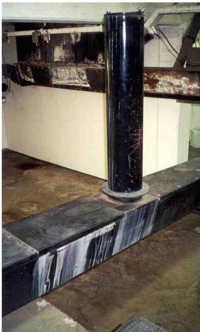
Figur 6.9. Cyklonasken ledes til transportsnegl på Hurup Fjernvarmeværk
