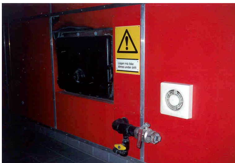
Figur 6.10. Bundasken blev udtaget direkte fra risten på Græsted Fjernvarme.
