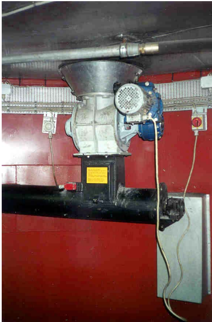
Figur 6.4. Fil teraske blev udtaget under posefil ter på Høng Varmeværk .
