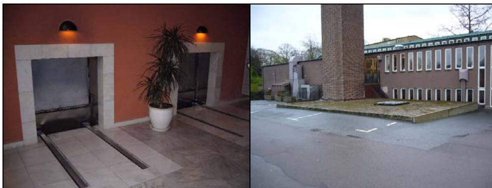
Figur 3. Lund Krematorium. Kælder findes under pladen foran bygningen. Udstyr kan hejses op og ned gennem lemmerne.
