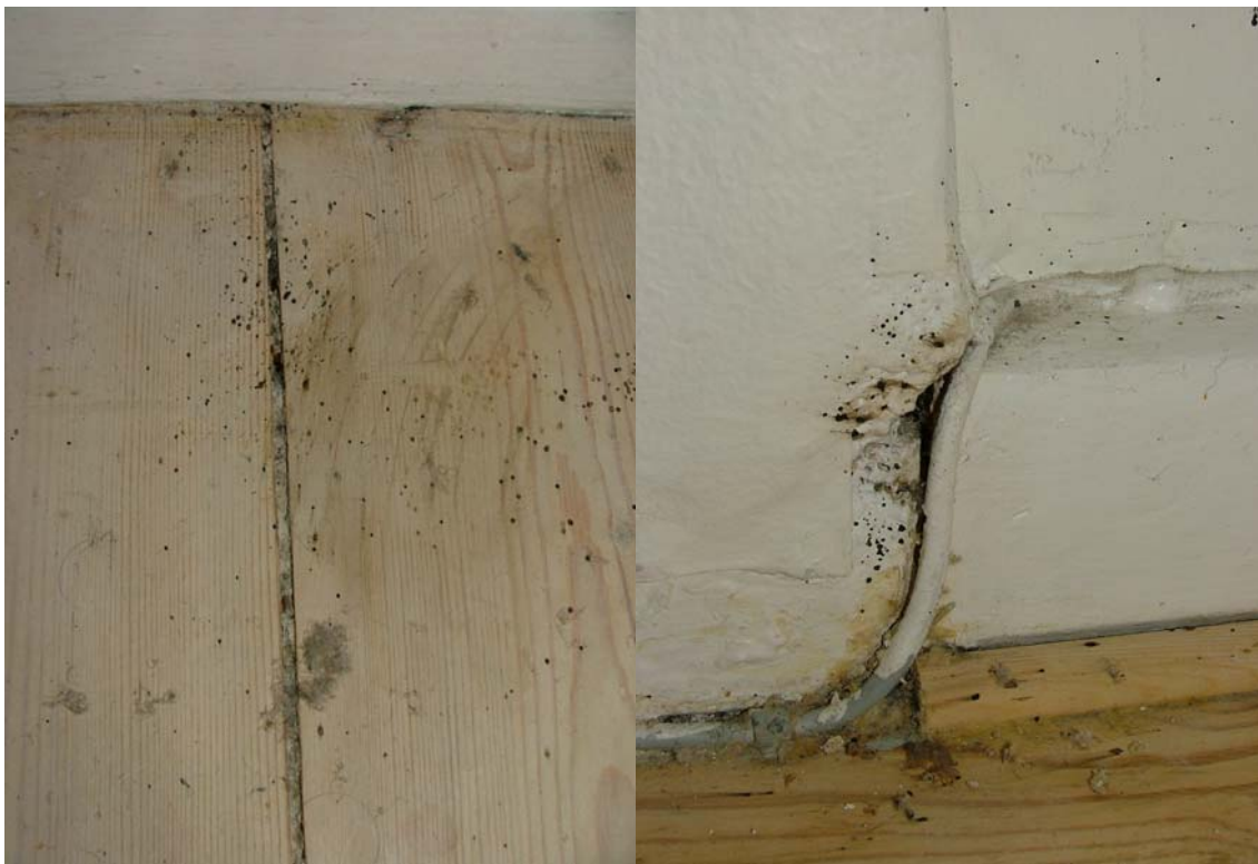
Figur 11. Væggelusgemmesteder mellem gulvbrædder og ved fodpaneler. De sorte pletter er væggelus ekskrementer
