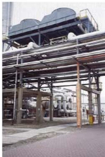
Figur 3.6 Eksempel på tørluftkølede væskekølere i en kemisk proces.
