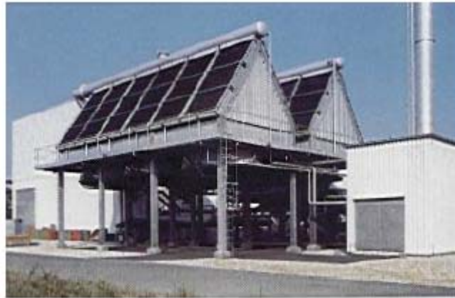
Figur 3.8 Eksempel på en luftkølet kondensator til kondensering af afkastdamp fra turbine.
