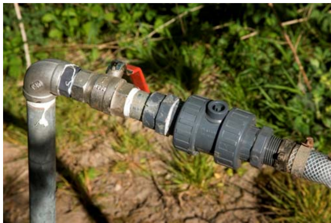
Kontraventil på tapsted forhindrer tilbageløb til ledningsnet. Foto: Jens Tønnesen, Dansk Landbrugs Medier.
