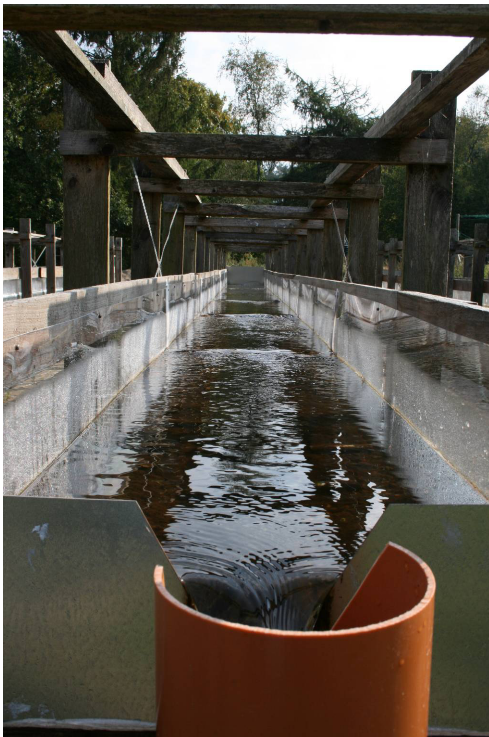
Figur 2.1.6. Afløbsenden af én af de 6 forsøgsrender i Lemming. Ud fra vandspejlshøjden i det skarpkantede V-overfald kan vandføringen gennem renden beregnes.
