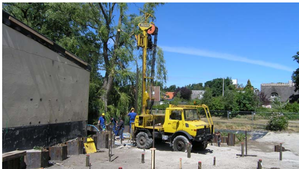
Termisk oprensning af chlorerede opløsningsmidler. Jorden varmes op, forurening og vand bringes på dampform og suges op af jorden. Foto: Region Hovedstaden.
