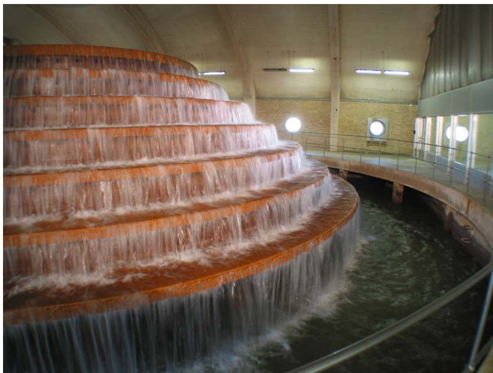
Itningstrappe på vandværk. Foto: Region hovedstaden.
