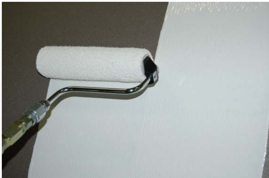
Fig. 5) påføring af 2 baner 2-k epoxygrundmaling med korthårsrulle.
