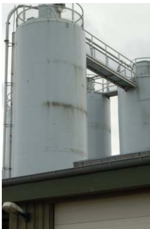
Regnemark Vandværk juli 2009. Overfladebehandlingen er i god stand, dvs. uden afskalninger, rustgennemslag eller andre filmfejl. På nordsiden (billedet th.) er der en del algevækst omkring svøbets svejsesamlinger. Algerne skæmmer udseendet, men det er alene et æstetisk spørgsmål.
