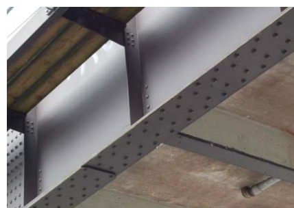
Jernbanebro ved Peter Bangs Vejens Station i København, juli 2009. Overfladebehandling intakt næsten overalt. Kun enkelte rustgennemslag ved profilkanter – muligvis som følge af mekanisk beskadigelse.
