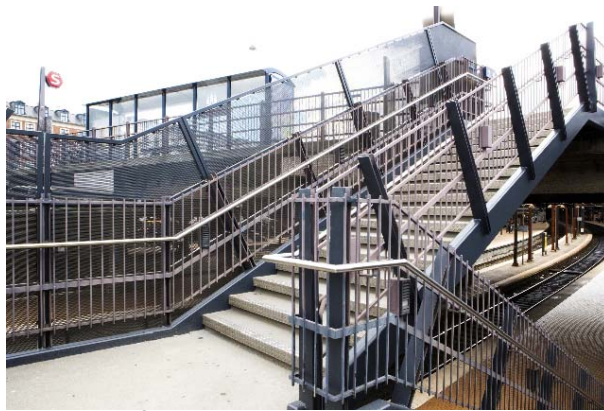
Før og nu. En af nedgangene under arbejdets udførelse tv. og efter færdiggørelse th. Bemærk den komplette inddækning af arbejdsstedet med stillads og presenning.
