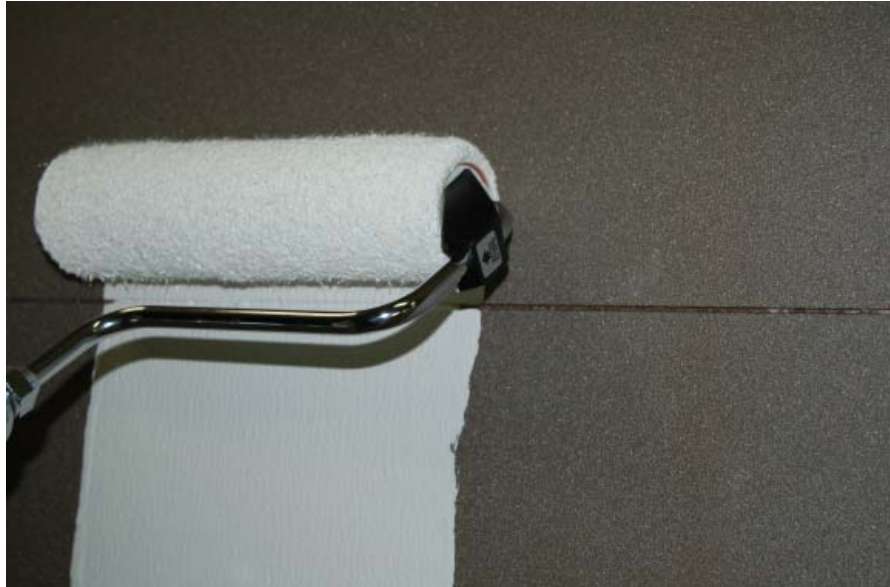
Fig. 4) påføring af 1 bane 2-k epoxygrundmaling med korthårsrulle.
