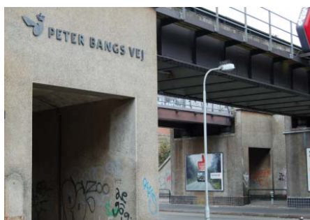
Jernbanebro ved Peter Bangs Vejens Station i København, juli 2009. Overfladebehandling intakt næsten overalt. Kun enkelte rustgennemslag ved profilkanter – muligvis som følge af mekanisk beskadigelse.
