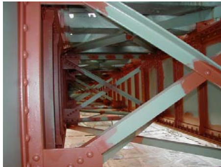
Stålkonstruktionen under Fiskebækbroen (jernbanebroen) undervejs i arbejdet (tv.) og efter færdigmaling
