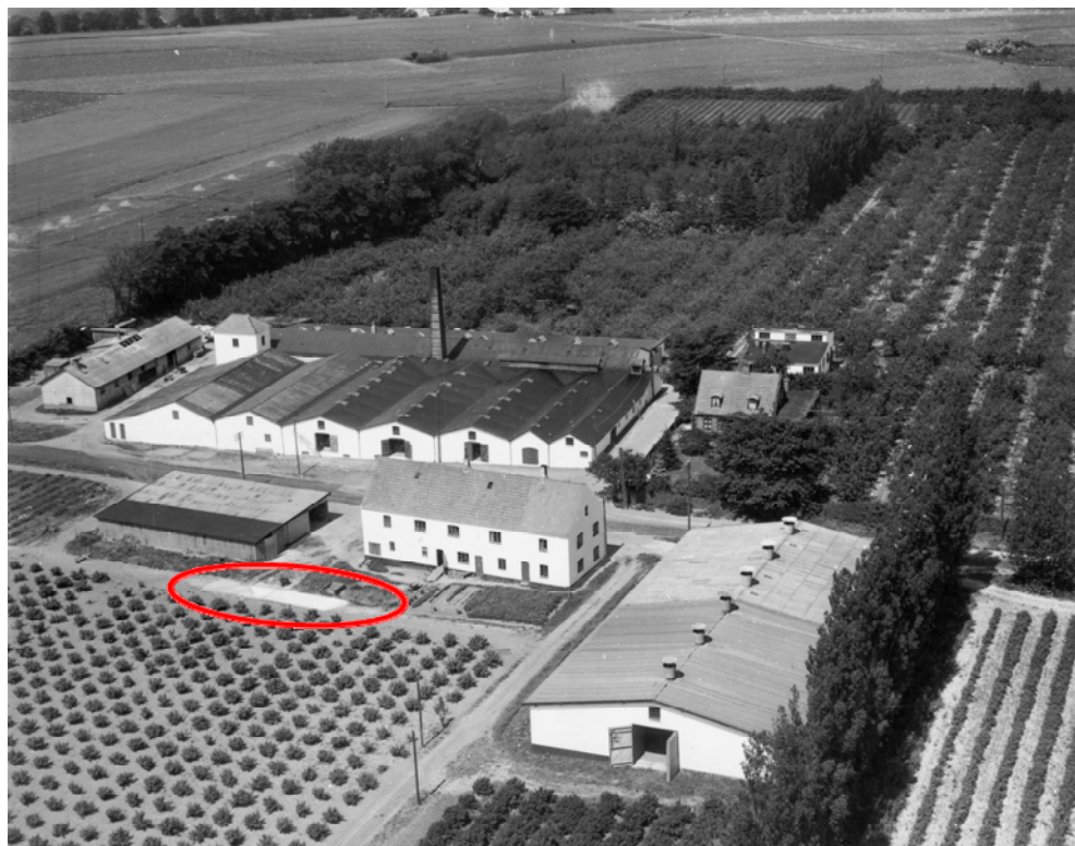
Figur 2. Luftfoto af vaskeplads og tilhørende betondæk (optaget i 1953).
