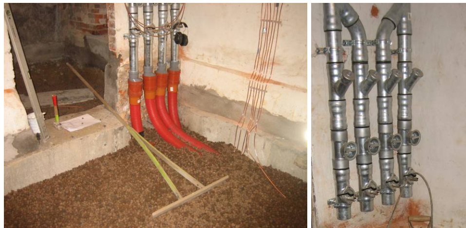
Figur 6.7: Kapillarbrydende lag af lecanødde med udlagte ventilationsdræn samt samling af afkastrør på Frederiksbjerg Torv i Århus.
