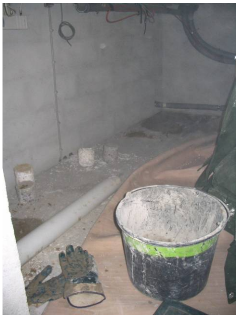
F3: Borearbejde, krybekælder
