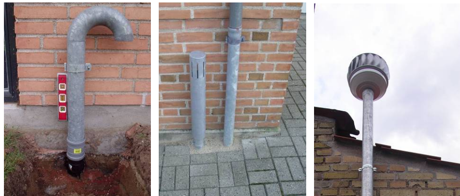
Figur 6.27: Eksempler på luftindtag og vinddreven ventilationshætte.
