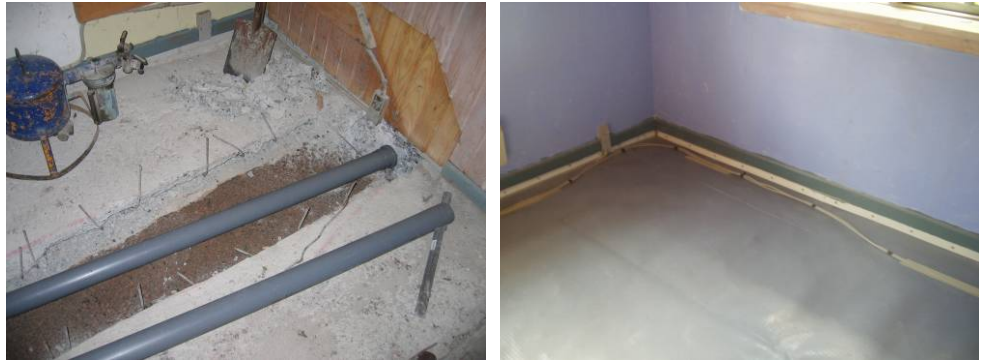
Figur 6.16: Bygning B – opbrydning af betondæk i render samt udlægning af R.A.C. membran. Fasanvej i Skuldelev.
