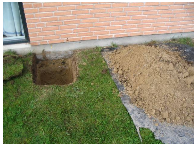
F14: Udgravning til svanehals ved nordligt fundament
