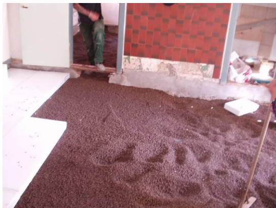
Figur 6.13: Udlægning af kapillarbrydende lag af lecanødder i bygning A, Fasanvej i Skuldelev
