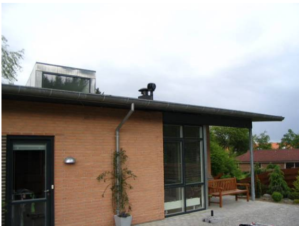
F13: Afkast fra krybekælder over tag, færdigetableret
