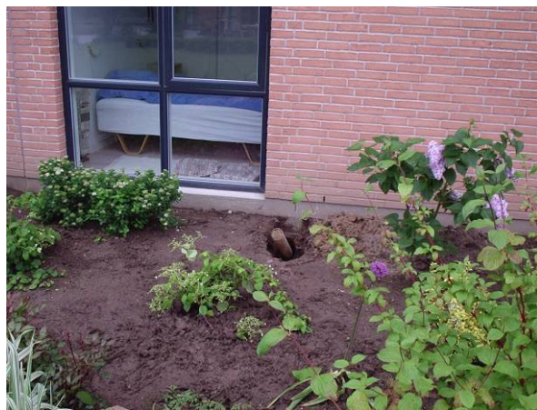
A3: Etablering af svanehals ved nordligt fundament
