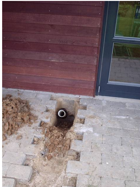
A2: Rørføring gennem fundament ved svanehals
