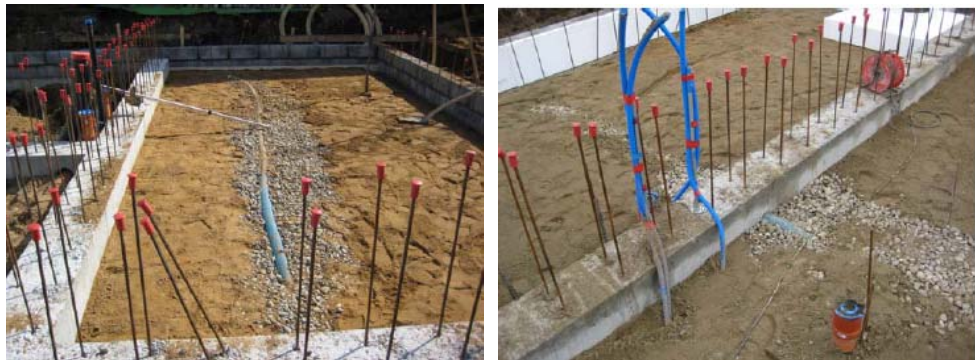
Figur 6.10: Udlægning af drænslinger under bygning. Levisonsvej i Kolding
