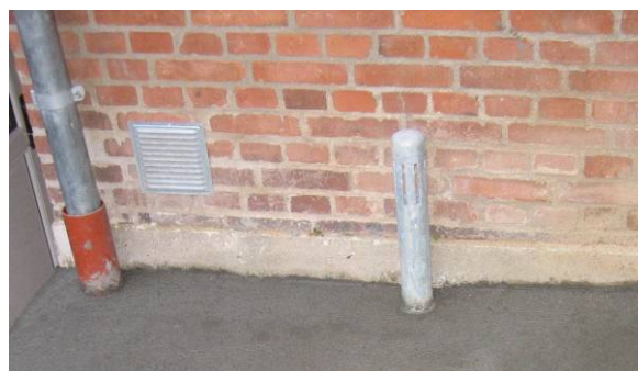
Figur 6.8: Luftindtag i galvaniseret stål. Frederiksbjerg Torv i Århus.
