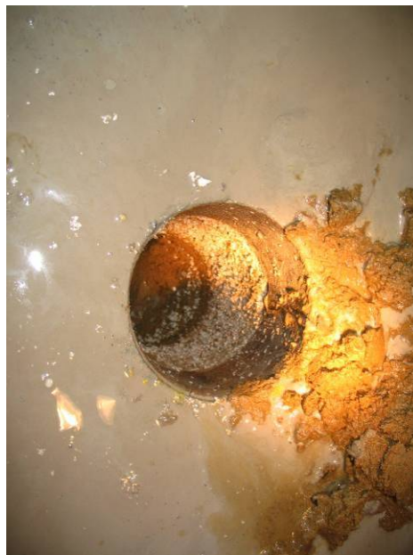
F4: Gennemboring af gulv i krybekælder
