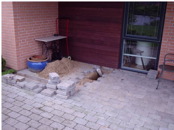
C1: Etablering af svanehals ved nordligt fundament
