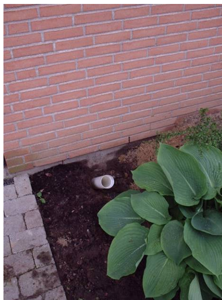
C4: Rørføring gennem fundament ved svanehals
