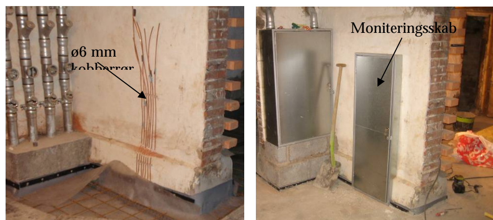
Figur 6.32: Eksempel på etablering af monitoringspunkter under gulv.
