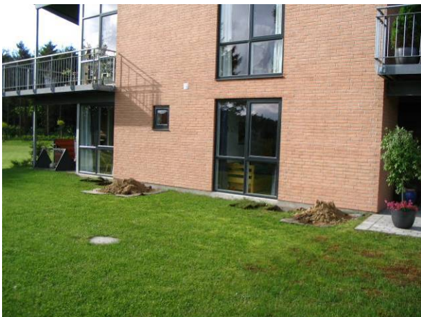
F15: Udgravning til svanehals ved nordligt fundament
