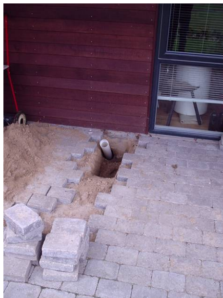
C2: Rørføring gennem fundament ved svanehals
