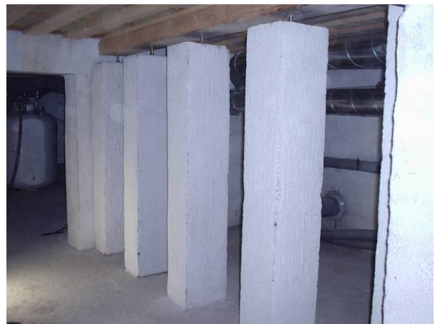
A8: Krybekælder ved ventilationsboring 2, ud
