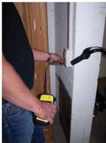
#38 Test 7: Gult niveau konstateret ved stikkontakt på skillevæg imellem kølderrum.
