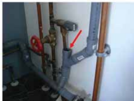
#8 Kondensaflob i bryggers med baggrundsudslag (rødt niveau).
