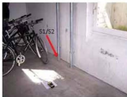
#10 Ventilationsrør benyttet til injektion under Test 7 – injektionsslangen kunne ikke føres forbi bøjning under gulv.
