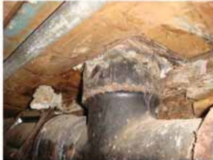
#7: Før tætning: Rørgennemføring fra lille WC i stueplanet.
