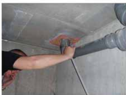
#33 Test 5: Udledning ved rørgennemføring til gulvaflob i bruser (lejl 13B).
