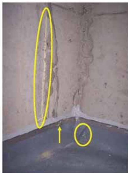
#22 Test 1: Indtrængning i krybekældervæg ved stobeskel, skruehul og punkt på membran (gult niveau).
