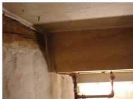
#14: Efter anden tætning: Opsat tætningskasse omkring rørgennemføringer i det nordvestlige hjørne af kælderen.
