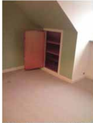
#80: Der blev målt med detektoren i skunken på loftsetagen.. Der er også udført en ATD-rørs måling.
