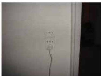
#17: Stikkontakt i stue i 1. th. med positivt signal.
