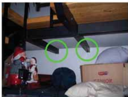
#37 Test 8: Ingen indtrængning ved trappens forankringspunkter i hulmur imellem (grønt niveau).
