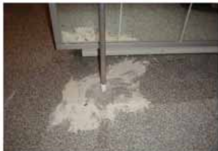
#1: Injektionspunkt nr. 1 ved frisør.
