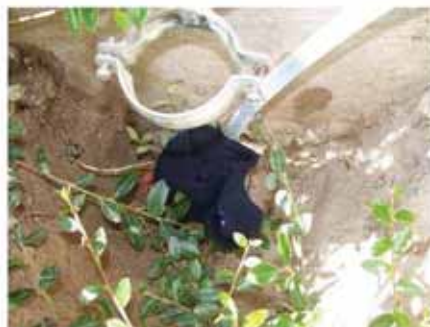
#2 Test 1: Udledning af sporgas i ventilationsdræn I3/I4 – tætning med våd klud.
