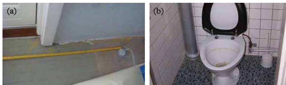
FIGUR 3.6: Spredning via støbeskel og ved faldstammer/rørgennemføringer.
