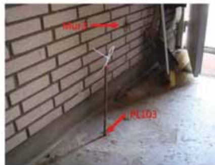
#6 Poreluftstation PL103 og Mur3.
