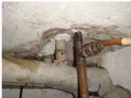
#23: Efter tætning: Fugning ved rørgennemføringer.
