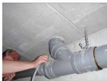
#34 Test 5: Udledning ved faldstamme til WC (lejl 13B).
