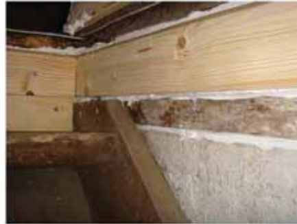
#20: Efter tætning: Fugning omkring træramme.
