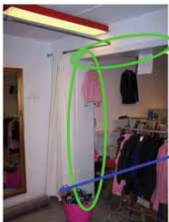
#29 Test 3: Der er ikke konstateret gasindtrængning ved den afblændede og tætnede murhvelving (grønt niveau).
