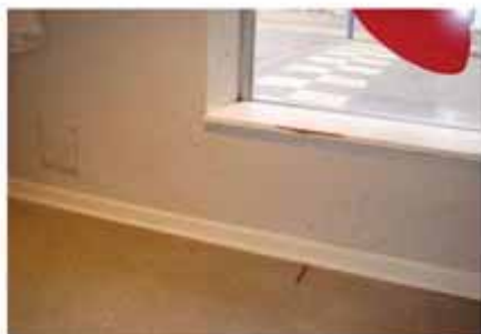
#3: Kontrolpunkt i væg ved frisør.
