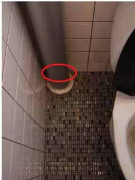
#27 Test 5: Indtrængning bag faldstamme (rødt niveau).
