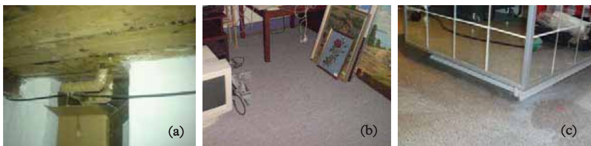
Figur 3.1: Eksempler på, at tæppe og linoleum stopper gennemtrængning af sporgas.
