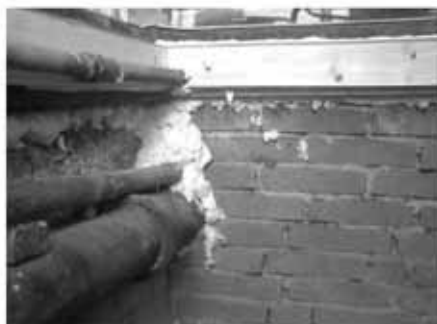
#17: Efter tætning: Fugning/skumning ved rør der leder hen til rørgennemføring syd for kælderlem.
