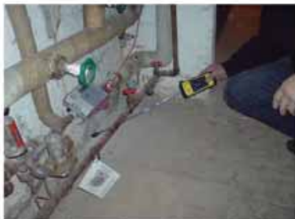
#73: Der blev målt med detektoren ved støbeskel, over gulvet samt ved rørføringer, der går gennem vægge og gulv.
