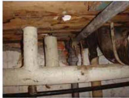
#4: Før tætning: Rørgennemføringer i nordvestligt hjørne af kælder.
