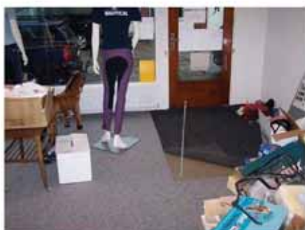
#9 Test 6: Poreluftpunkt PL7, hvor udledning af sporgas er foretaget i hulrum i gulvkonstruktionen.
