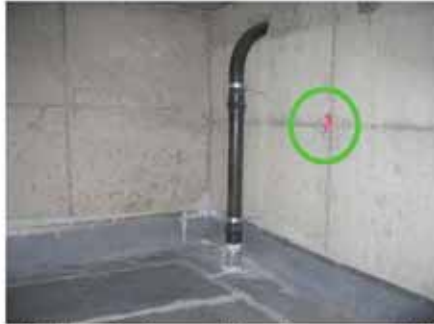
#25 Test 2: Der er ikke konstateret indtrængning ved støbehuller lukket med rødt PU-skum, eller i øvrige punkter på væggen eller i membransamlinger (grønt niveau).
