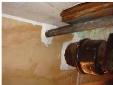
#15: Efter tætning: Fugning ved rør der leder ind i trækasse.
