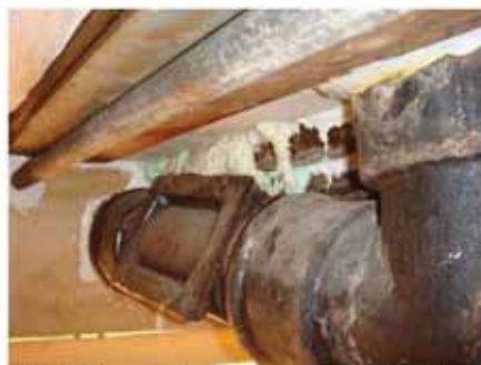
#16: Efter tætning: Fugning ved afløb fra WC.
