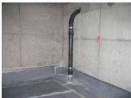
#9 Ventilationsrør benyttet til injektion under Test 2 – injektionsslangen kunne ikke føres forbi bøjning under gulv.
