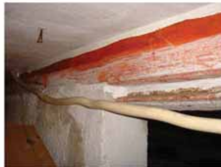
#24: Efter tætning: Fugning ved støbeskel i loft.
