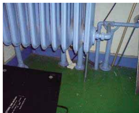
Figur 3.11: Spredning omkring rørgennemføringer igennem etageadskillelse.
