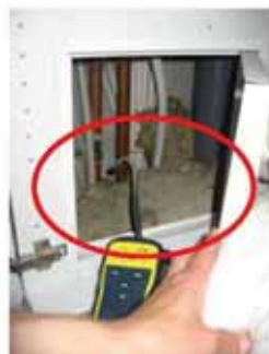
#30 Test 5: Indtrængning af sporgas i kabelskab i soveværelsesskab (rødt niveau).
