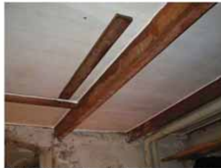
#22: Efter tætning: Beklædning opsat på underside af kælderloft.
