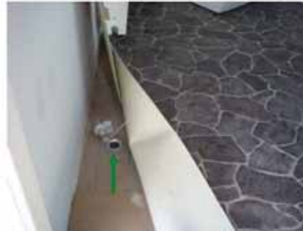
#2 Kontrol-/injektionspunkt MP102.
