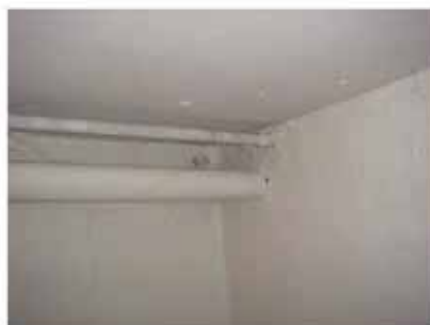
#16 Rørgennemføring til væg (værelse).
