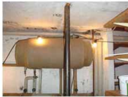
#6: Før tætning: Rørgennemføringer i det vestligste kælderrum.
