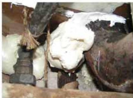
#13: Efter første tætning: Fugning/skumning af rørgennemføringer i det nordvestlige hjørne af kælder.
