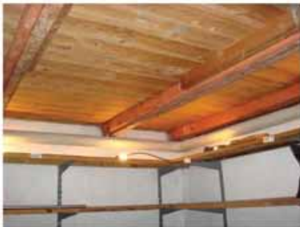
#5: Før tætning: Træloft i det østligste rum.
