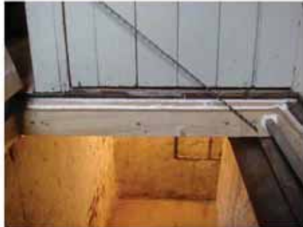
#19: Efter tætning: Træramme monteret på eksisterende konstruktion ved kælderlem.
