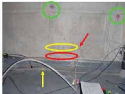
#20 Test 1: Indtrængning ved tilmuret hul i krybekældervæg (gult og rødt niveau) og fuge ved overlappende membranbaner (gult). Der er ikke konstateret indtrængning ved støbehuller (grønt niv.).
