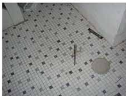
#4 Kontrolpunkt 4 (ved trappe).
