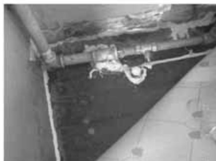
#18: Efter tætning: Fugning ved rørgennemføringer syd for kælderlem.
