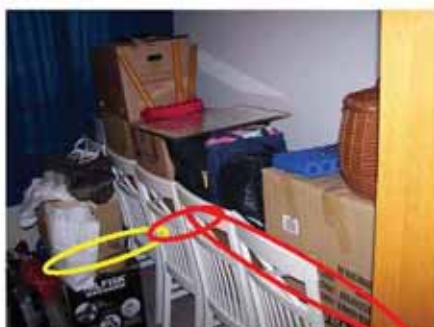
#33 Test 7: Indtrængning af sporgas langs støbeskel, i pulterkammer tilhørende lejemalet (rødt og gult niveau).
