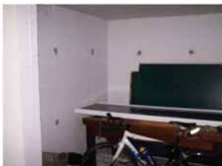
#11 Rum med vanskelige adgangsforhold i den sydlige del af kælderen.
