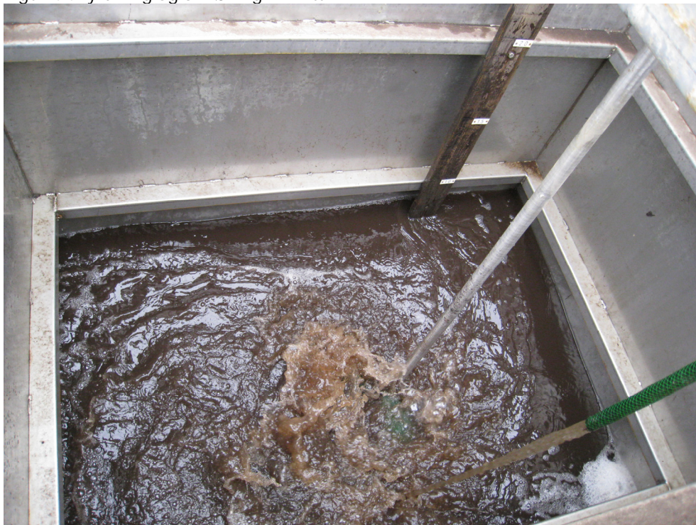
Figur 4.4 Fyldning og omrøring i 2 m 3 tank
