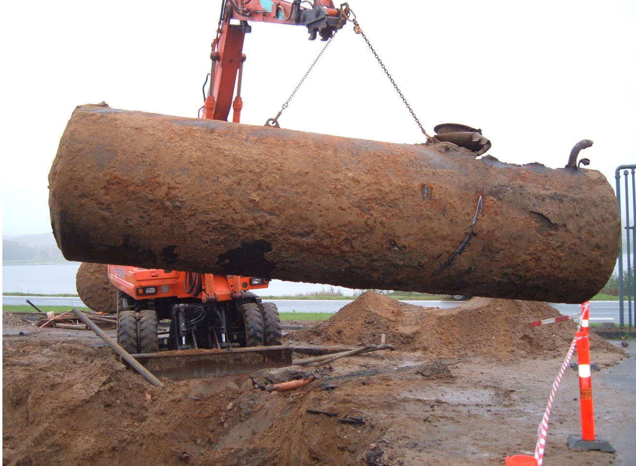
Opgravning af benzintank i forbindelse med oprensning af forurening på en nedlagt tankstation.
