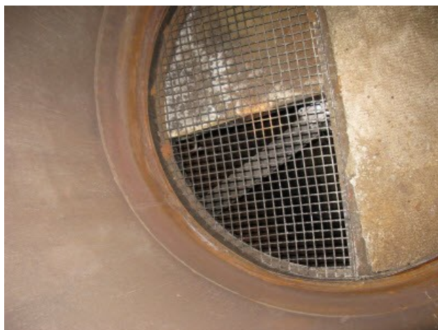
Figur 26 Foto ovenfra af drejespjæld i stilling ca. 90 grader.
