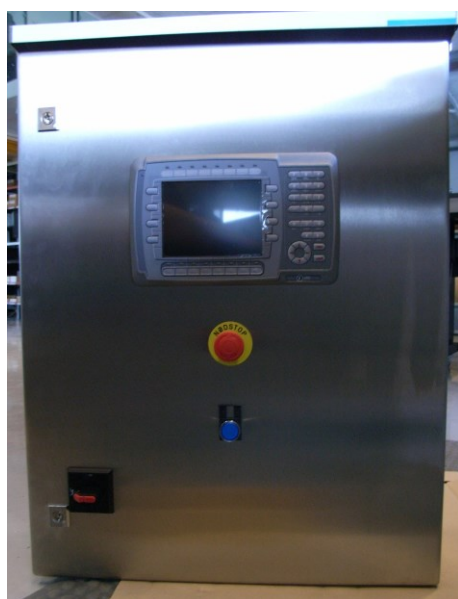
Figur 29 Kontrolpult i vejrbestandig kasse.
