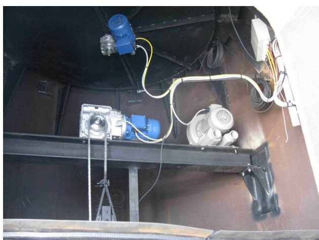
Figur 28 Motorer til drejespjæld og kammerbund. Desuden ses gear til kæde-træk og en køleluftblæser.
