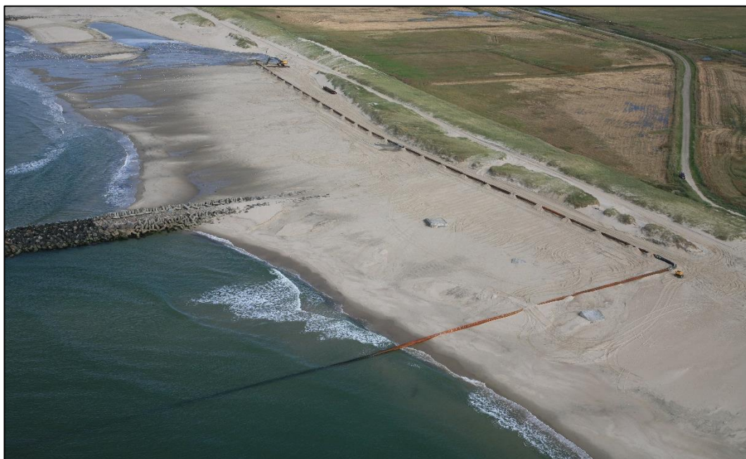
Figur 3-7. Indpumpning med bundliggende rørledning hvor sandet fordeles parallelt med stranden.
