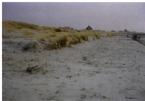
Figur 8-24. Erosion i nydannet klit mellem p-plads og hofde 1 efter oktoberstormen i 1998.
