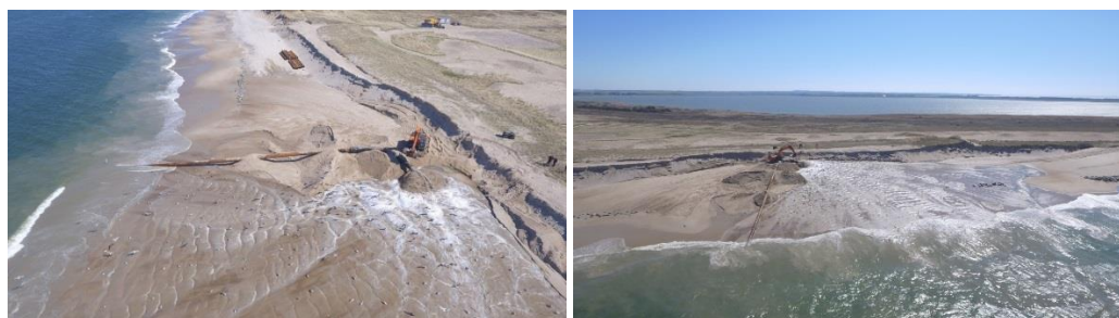
Figur 8-25. Eksempel på strandfodring på Vestkysten.
