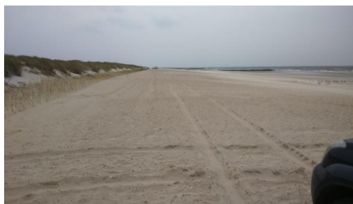
Figur 6-35. Stranden efter det indpumpede sand er udjævnet med en gummiged og der er plantet hjælme ved foden af klitrækken.
