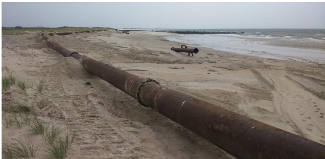
Figur 3-8. Indpumpning med bundliggende rørledning ved Blåvand.
