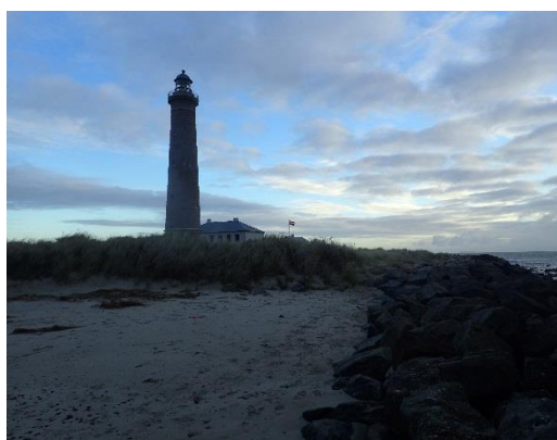
Figur 7-28. Eksisterende skråningsbeskyttelse ud for Det Grå Fyr.
