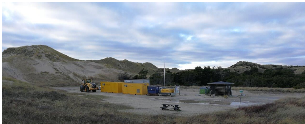
Figur 3-19. Foto fra arbejdsplads ved Damstederne.
