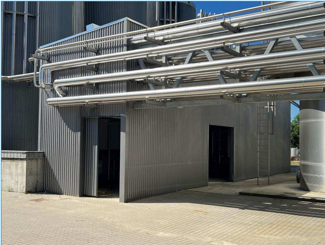
Figur 2 – Foto af bygningen som olieumpen placeres i.
