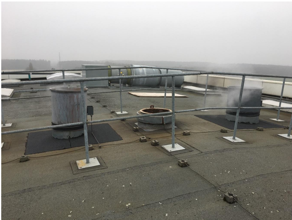
Figur 29: Afblæsning fra opstartsventil over tag (midterste afblæsning)
