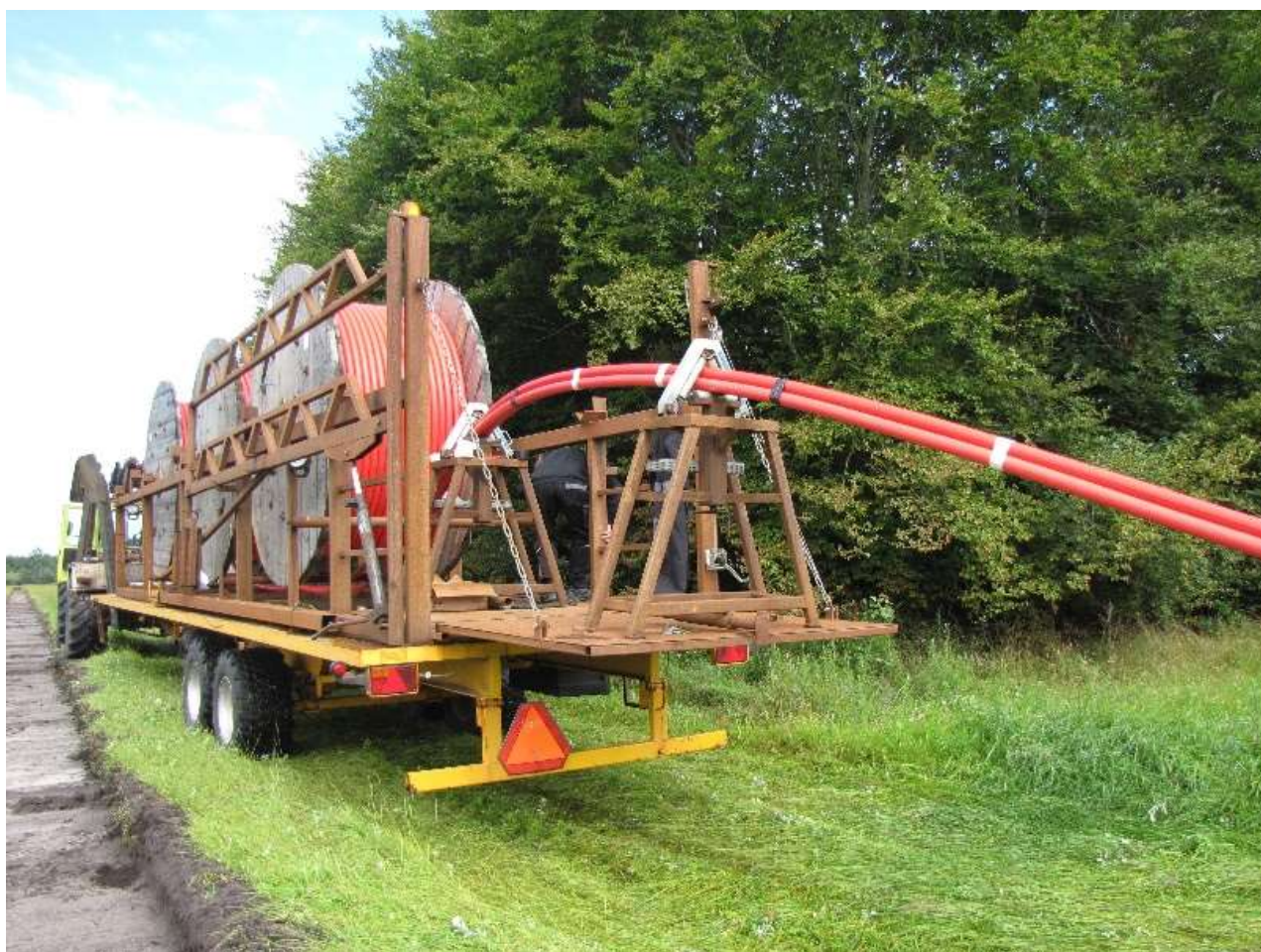
Figur 10-11 Vogn med kabeltromler som benyttes under udlægning af kabler
