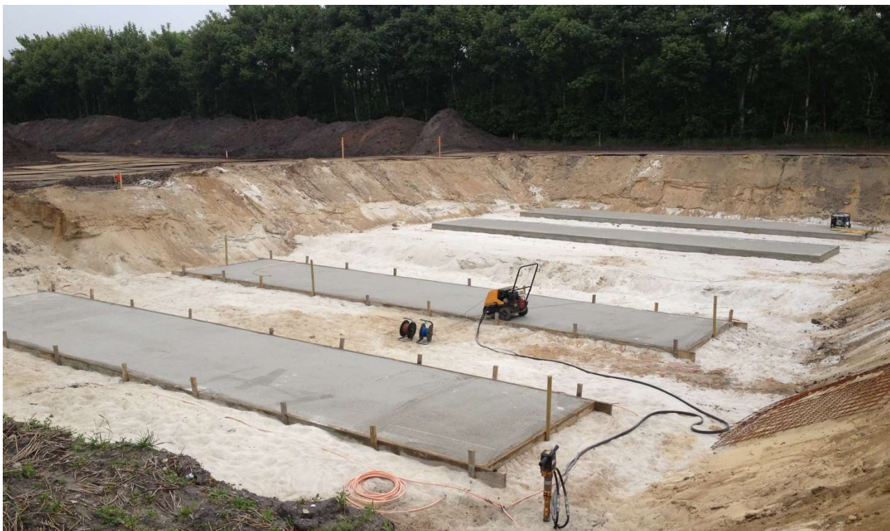
Foto 5-3 Længs kabelstrækningen vil der være behov for at etablere muffegrave hvor kabelenderne samles. Tilstedeværelse i disse områder vil være længere, mens anlægsbæltet ved muffegravene kan være lidt bredere end anlægsbæltet langs kabelgravene.
