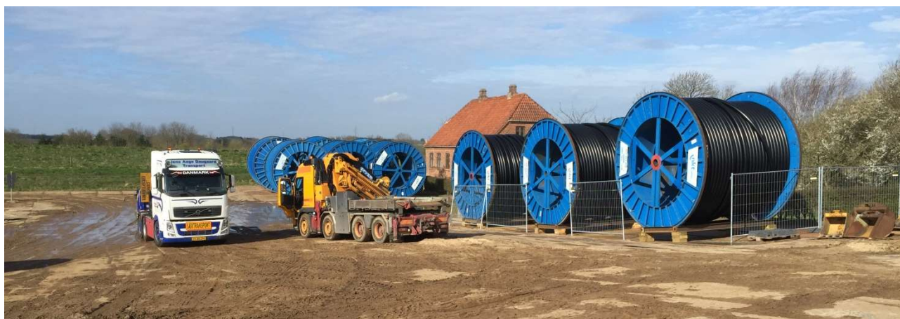
Foto 5-3 Opbevaring af kabeltromler med jordkabel på tromledepotplads langs anlægsbæltet
