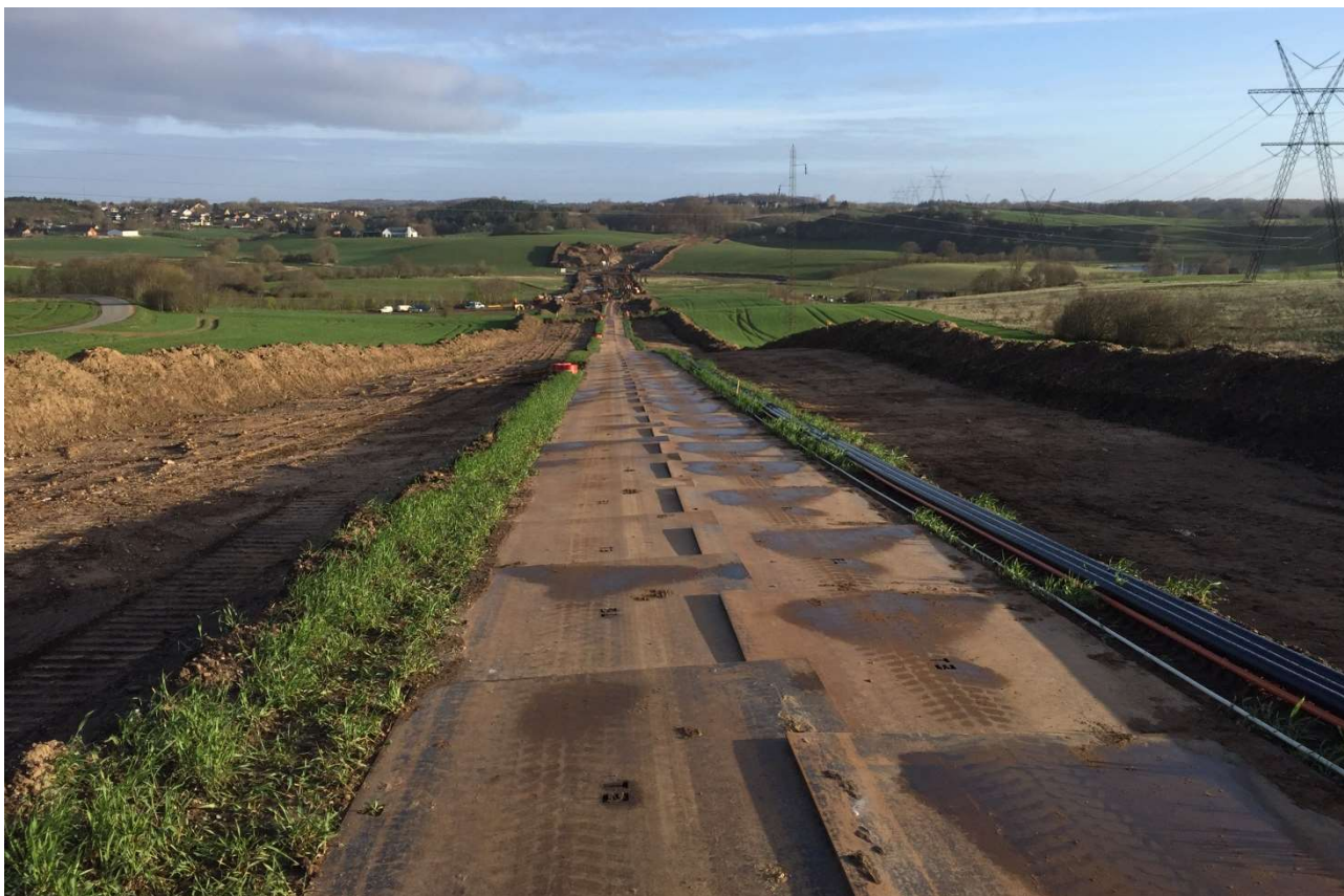
Foto 5-2 Eksempel på et afrømmet arbejdsbælte til dobbelt kabelgrav, lige inden gravning af selve kabelgravene. I dette projekt vil anlægsbæltet være ca. dobbelt så bredt, da der skal laves 4 kabelgrave.
