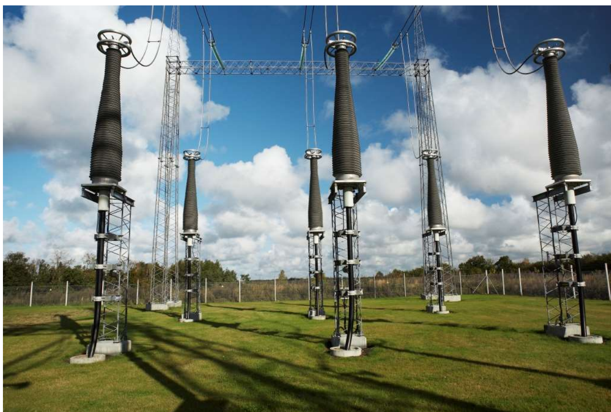
Foto 9-1 Fundamenter under el-tekniske komponenter
