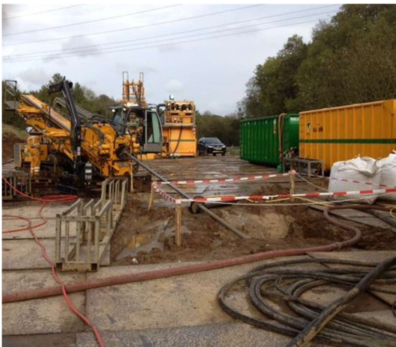
Foto 6-1 Eksempel på arbejdsareal ved lang styret underboring.
