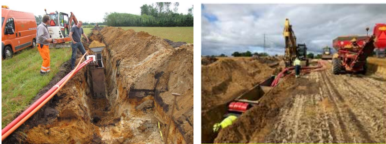
Figur 10-10 Udlægning af 60 kV kabelanlæg i åben grav
