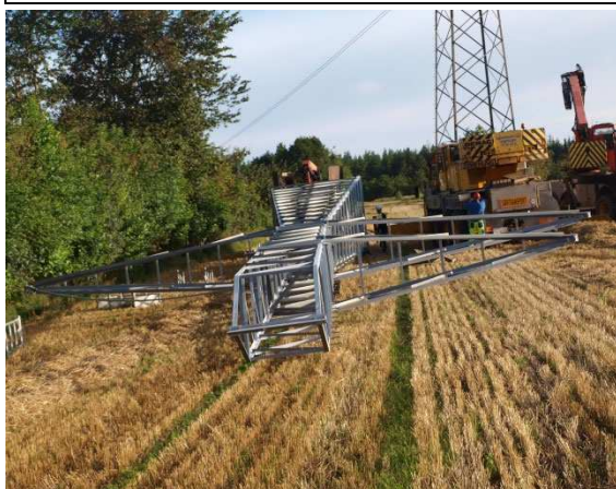
Ny mast klar til at blive udskiftet med gammel mast.
