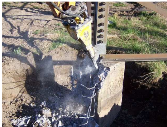
Vinkeljernet, som mastens ben er forankret til, metalliseres. Fundamentet støbes op igen.
