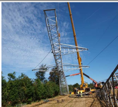
Ny mast rejses med mobilkran.
