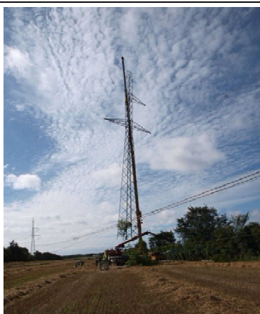
Gammel mast tages ned med kran i ét stykke.
