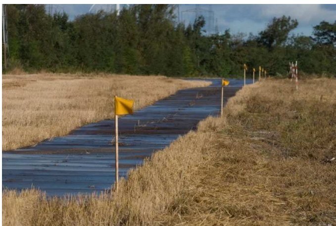
Adgangsvej med køreplader
