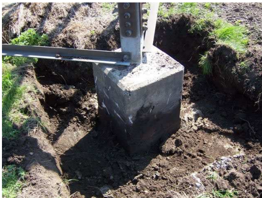
Soklerne graves fri. Den del af soklen, der er dårlig, fjernes.
