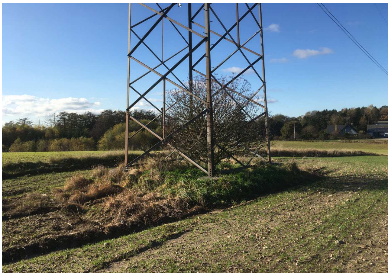
Figur 9: Foto, der viser den nederste del af mast nr. 140. Fundamentets øvre del med sokler kan anes. Jorddækning ved fundamenterne har til tider besværliggjort eftersyn.
