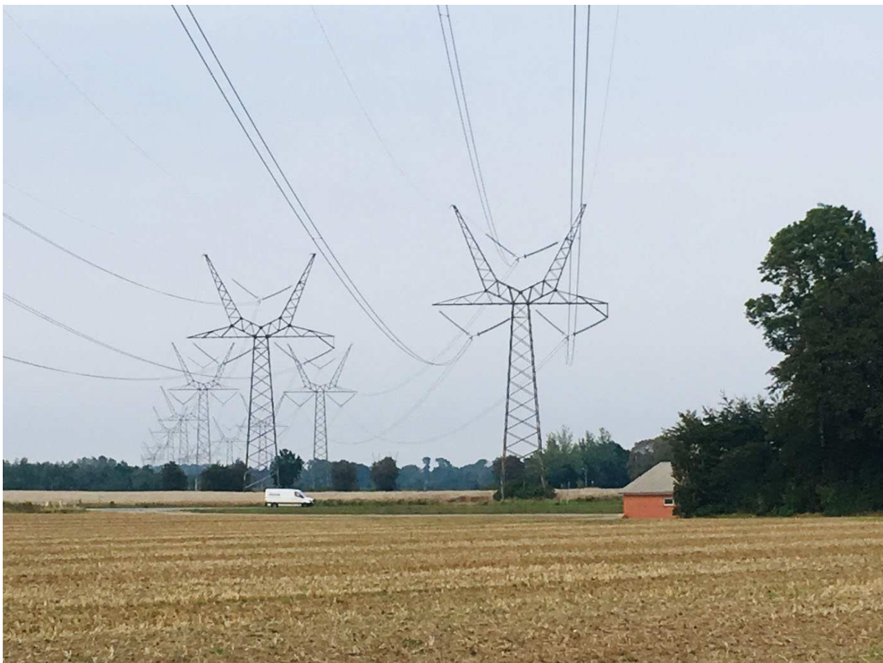
Figur 2: Her er vist både den nordlige og den sydlige strækning mellem Kauslunde og Fraugde. Masten længst til højre ligger på den sydlige strækning, - den ældste strækning som skal vedligeholdes. Det er mast nr. 220 set fra mast nr. 219 i nærheden af landsbyen Volderslev, syd for Odense.
