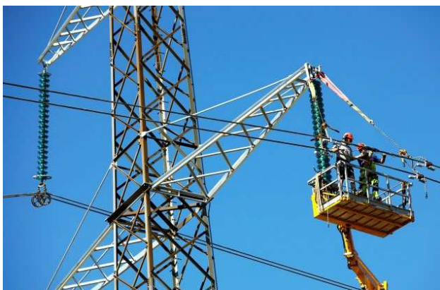
Hjul fastgøres for enden af isolatorkæden fra en mandskabslift.
