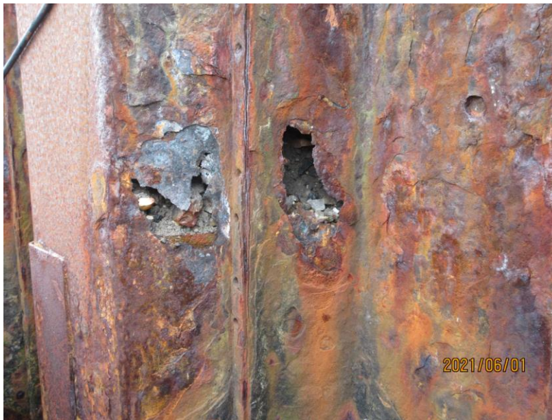
Figur 3-4: Den nordvendte kropsplade havde større huller langs det meste af strækningen. Hullerne sås at have større hulrum bag spunsen. Fælles for alle hulrum var at der blevet observeret en form for lagdeling med et net eller presenning.
