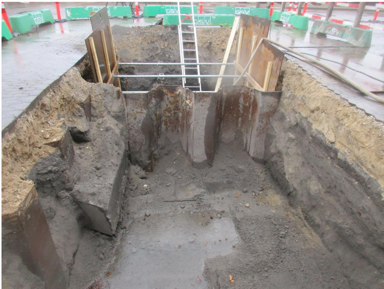
Figur 4-10: Oversigtsbillede af opgravningen placering A. Bemærk, øverst ca. 0,5 m gult sand og derunder mørkegrå flyveaske.
