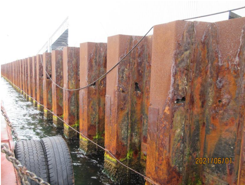
Figur 3-3: Der blev set en generel tendens med huller i den nordvendte kropsplade. Hullerne blev hovedsageligt fundet i samme højde, højt over splash zonen, hvor der i det bagvedliggende materiale kunne ses en form for lagadskillelse.
