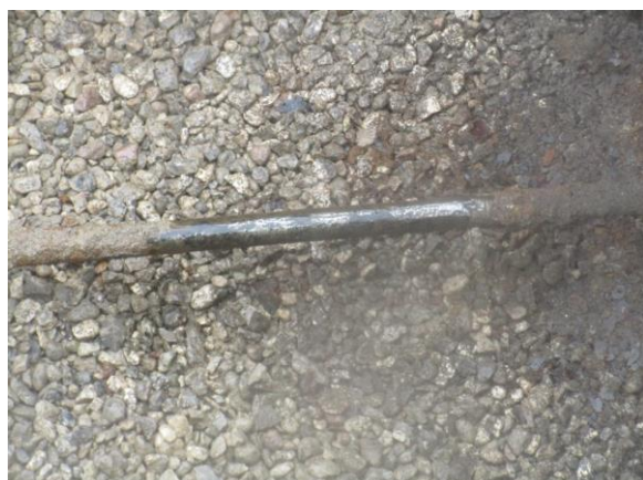
Figur 4-12: Anker, hvor overfladen er rengjort med stålborste.
