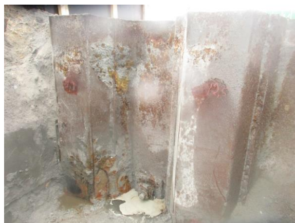
Figur 4-13: Spunsens overflade, billedet er sløret grundet konstant regn under inspektionen.
