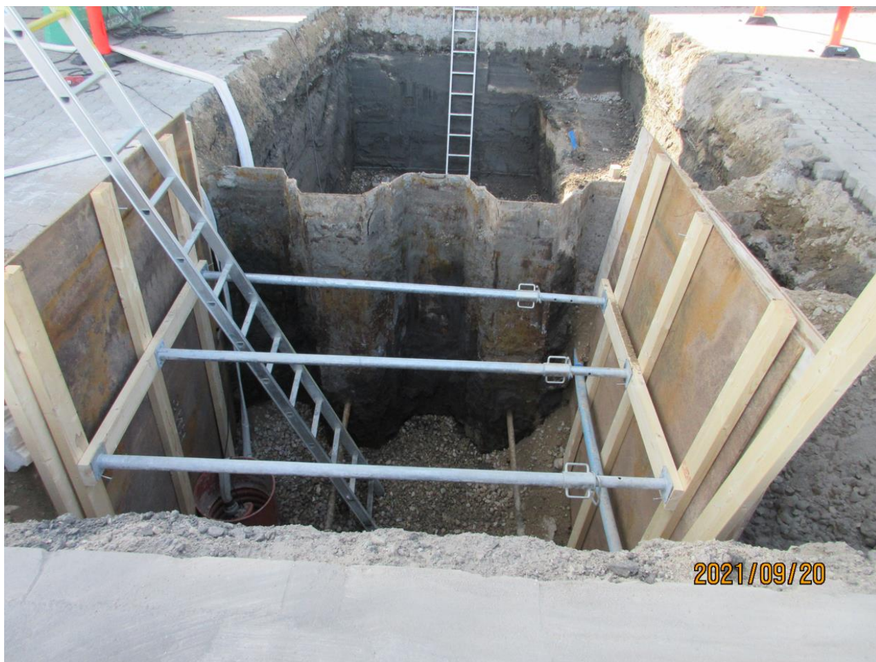
Figur 4-2: Overbliksbillede af opgravningen ved placering D0.
