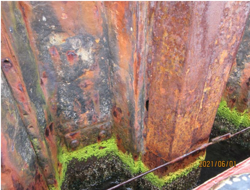
Figur 3-2: Der blev flere steder observeret synlige huller udenfor de påsvejste stålplader nær splash zonen.
