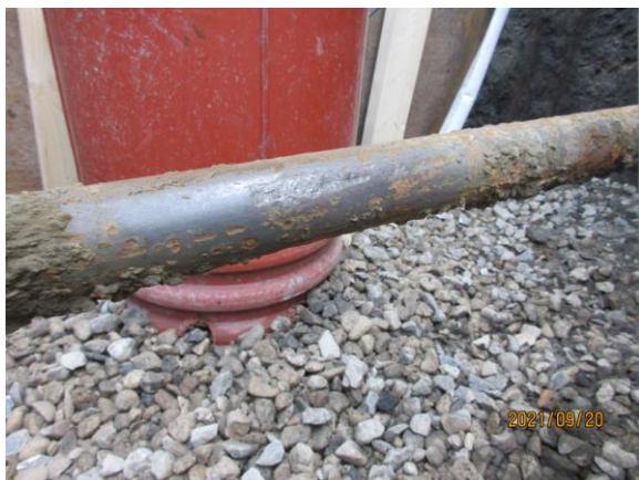
Figur 4-4: Børstet anker, diameter 45.5 mm.
