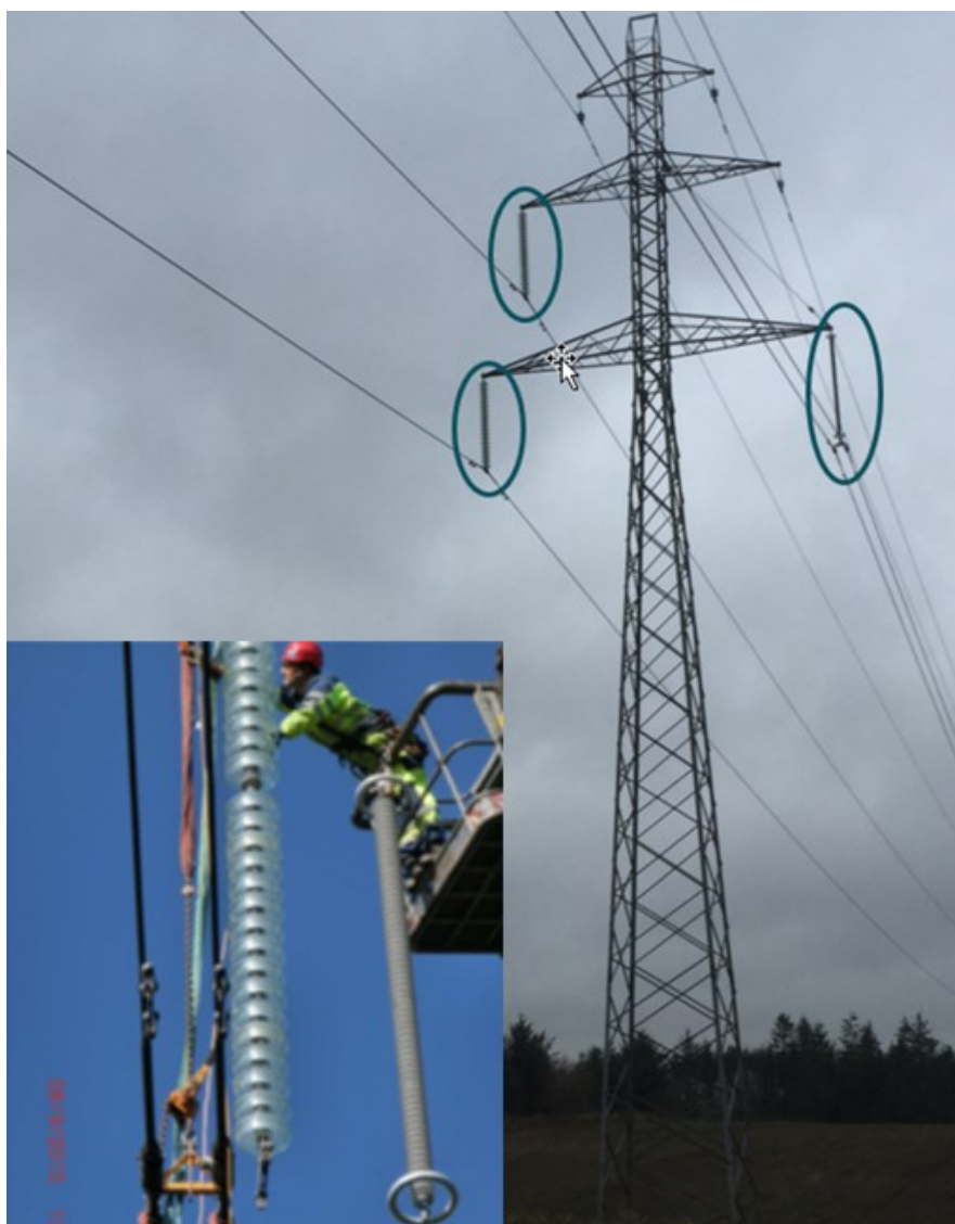
Figur 4-14 Mast på strækningen Bulbjerg–Tjele efter udskiftning af isolatorkæde. Til venstre på masten hænger to ledere i hver sin glasisolatorkæde. Til højre hænger en "dobbel leder" på en isolatorkæde af komposit. I det indsatte billede udskiftes glasisolatoren på strækningen Bulbjerg-Tjele i 2015. Billedet viser forskellen på til venstre glasisolatoren og til højre kompositisolatoren inden udskiftning.
