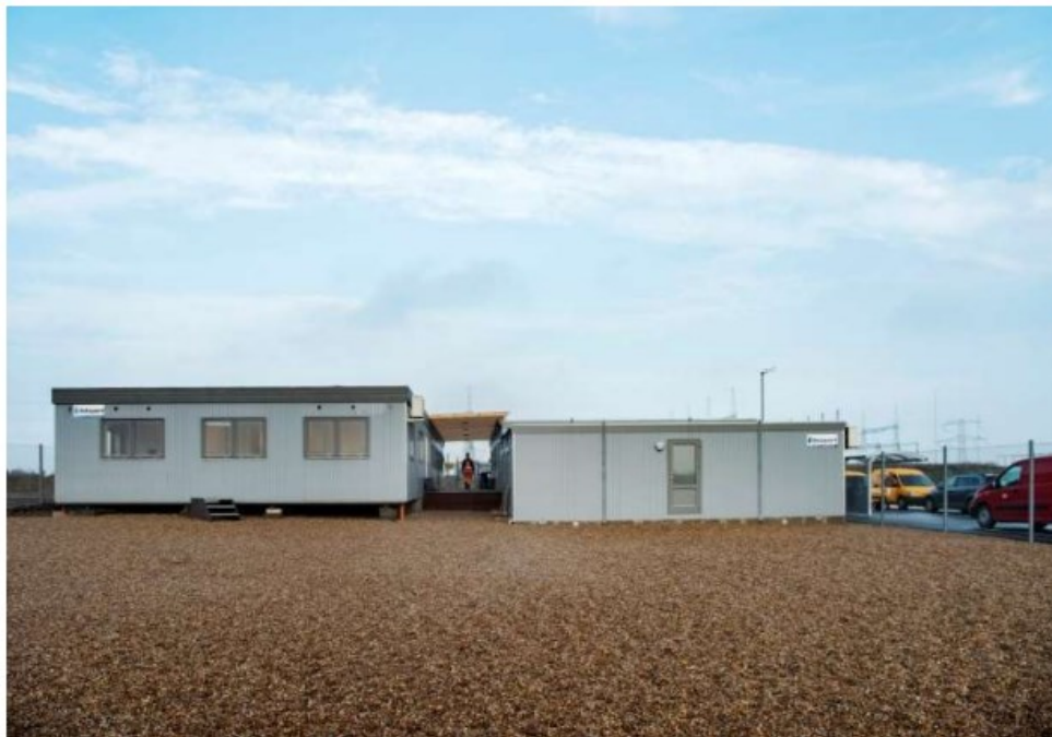
Figur 4-19 Eksempel på en oplagsplads med tilhørende skurby
