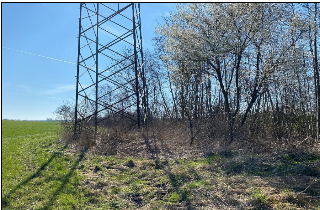
Figur 8-3 Mast 96 som står yderst i en § 3 registreret mose, tæt på dyrket mark. Fra Swecos besigtigelser i april 2025.
