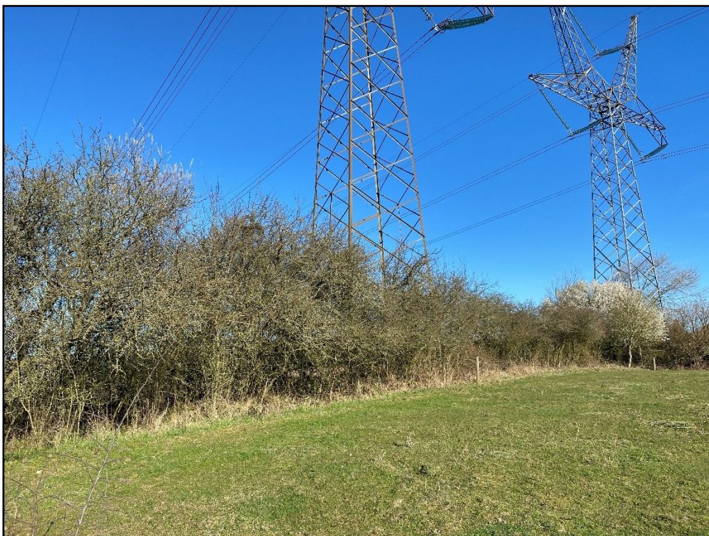
Figur 8-26 Mast 163 ligger højt, og står i et levende hegn ved en afgræsset mark. Fra Swecos besigtigelser i april 2025.
