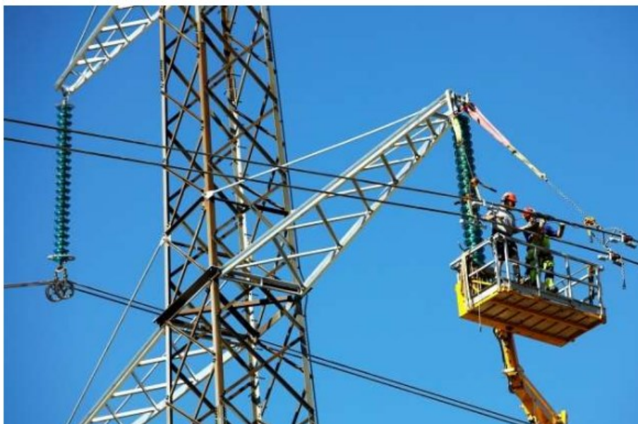
Figur 4-16 Lift med mandskab som er i gang med at fastgøre hjul på isolatorkæderne, forud for gennemtrækning af leder.
