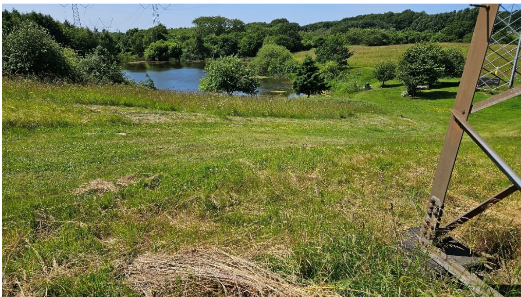
Figur 7-49 Mast 174. Fra masten set mod vest, ned mod registreret overdrev og sø. Tæt på masten ses en slået sti ned mod søen
