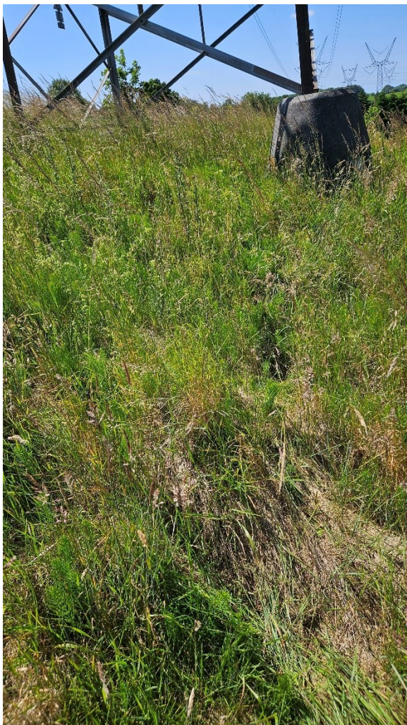
Figur 7-38 Mast 170 – nærbillede af vegetationen tæt på masten i juni 2025. Det ses at der ligger en del græsforne fra tidligere år.
