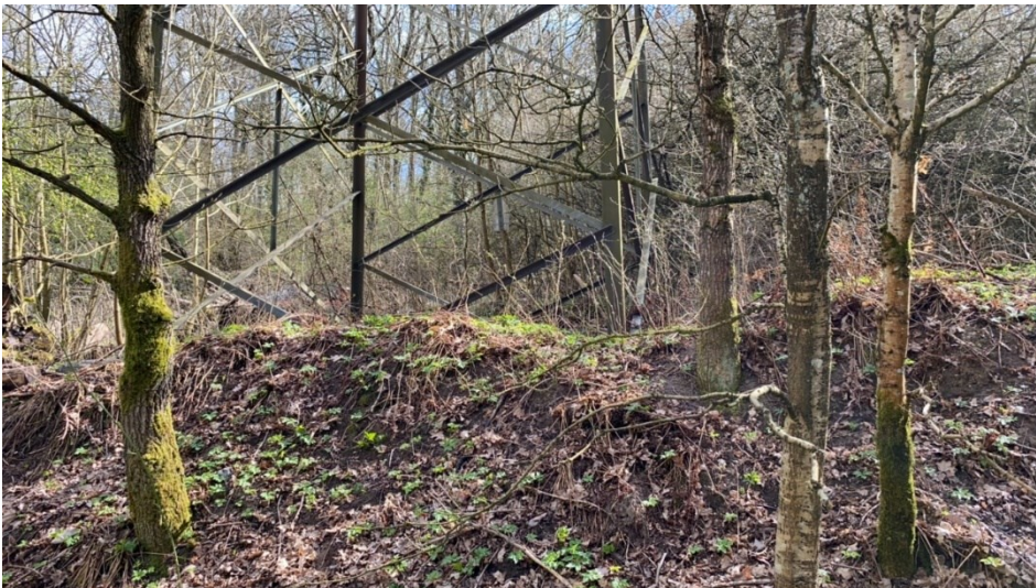
Figur 10-6 Mast 134 set fra nord, med det meget høje jorddige på næsten 1,6 meter i forgrunden
