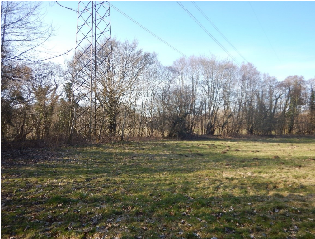
Figur 7-51: Indsigt til mast 206 fra et afgræsset areal. Selve masten står i krat, lige oven for skrænten ned mod Odense Å, som er kortlagt som Elle- og askeskov og vejledende registreret som beskyttet mose.
