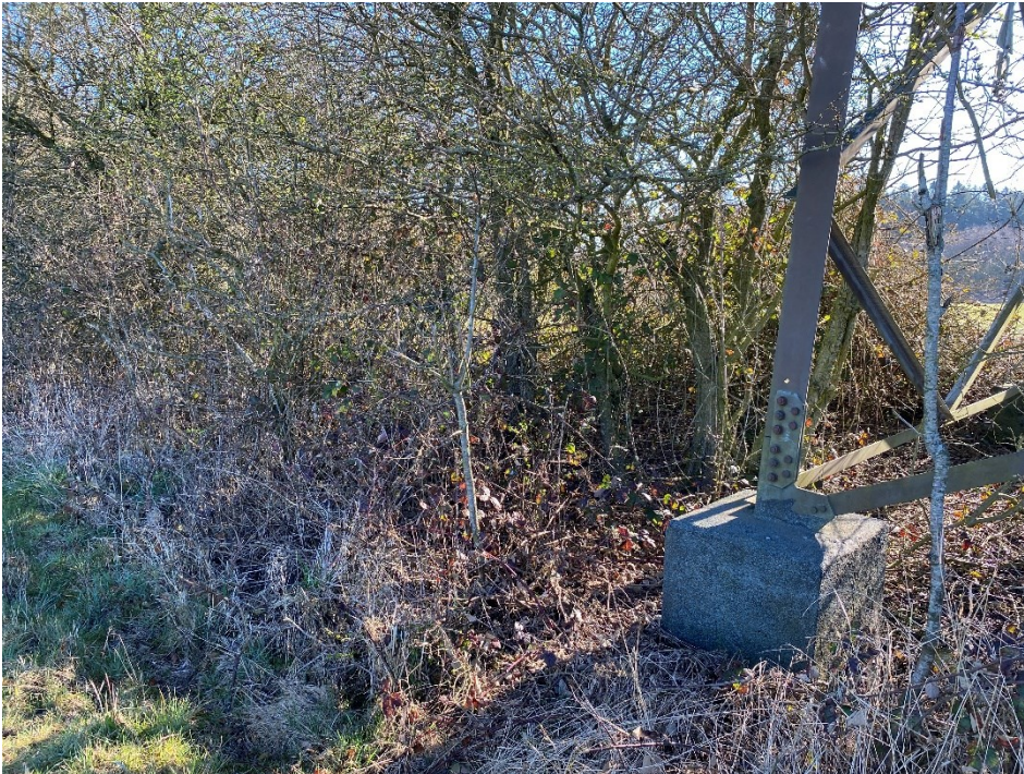
Figur 10-7 Tæt bevoksning, men intet erkendbart dige ved masten.
