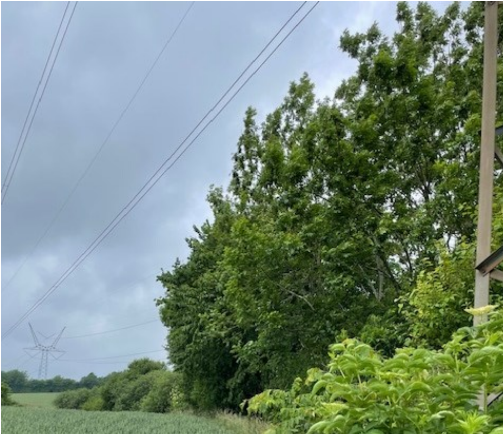
Figur 8-44 Det levende hegn ved mast 118 set fra syd.
