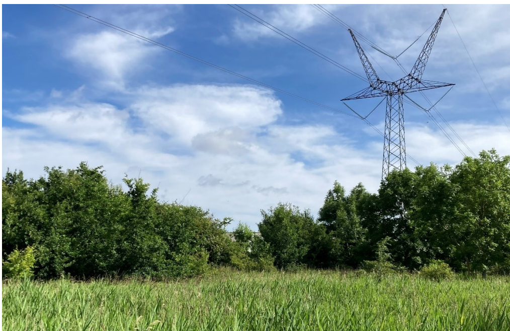
Figur 8-49 Arbejdsarealet ved mast 226 indeholder spredt opvækst
