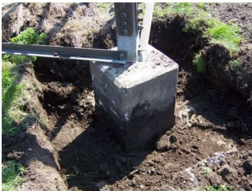
Figur 4-7 Eksempel på en frigravet sokkel.
