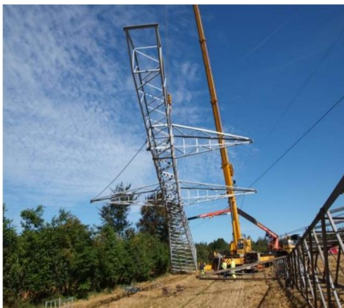
Figur 4-12 Ny mast er ved at blive rejst med mobilkran. Den gamle mast ses liggende til højre. Masterne på billedet er mindre end masterne i dette projekt. I dette projekt arbejdes der på køreplader.
