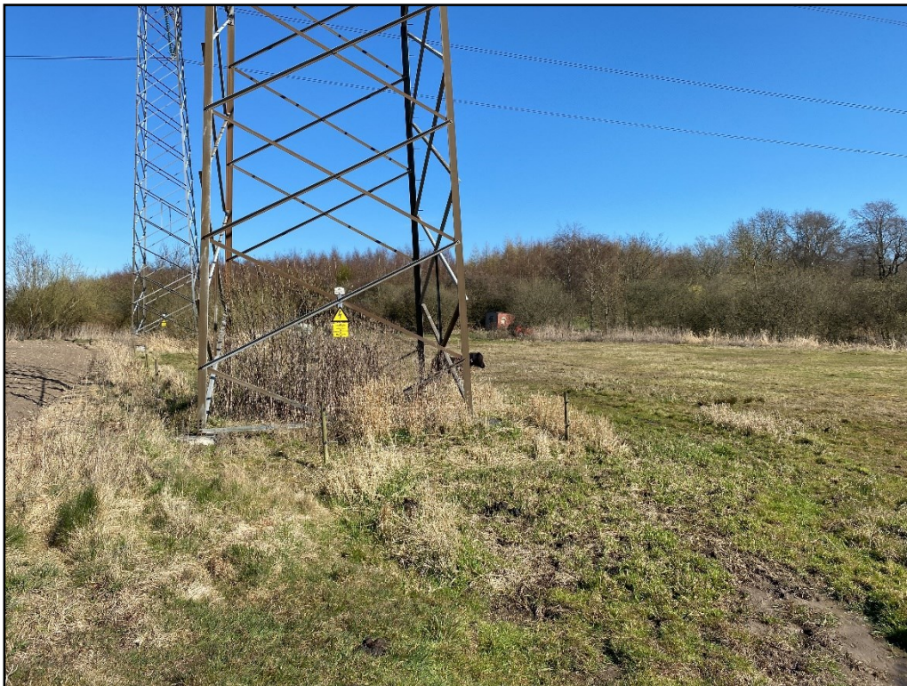
Figur 8-2 Mast 95 står på et areal som er vejledende registreret som eng, med dyrket mark mod vest og hesteafgræsset fold mod øst. Fra Swecos besigtigelser i april 2025.
