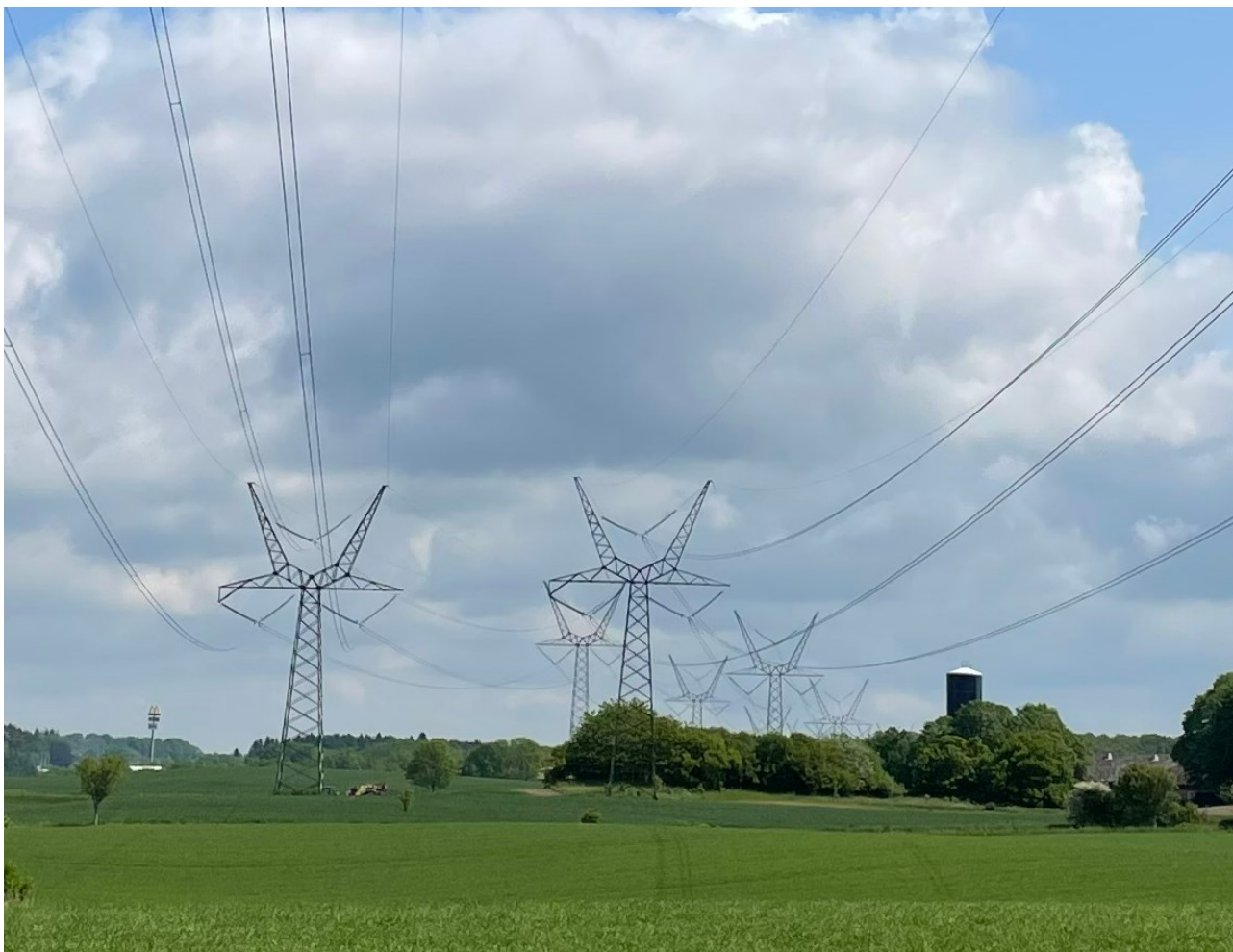
Figur 9-13 Eksempel på den øgede kompleksitet, som 400 kV-luftledningsanlægget mellem Kauslunde og Fraugde (fra 1973) vil optræde med, når man ser på langs med retningsændringer (knæk), og når anlægget ses i kombination med et 400 kV-luftledningsanlæg fra 1990. Foto: NIRAS A/S.
