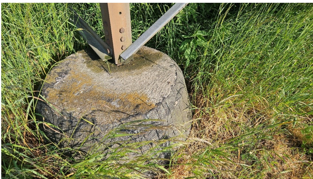
Figur 4-5 Sokkel uden asbest. En sort overfladebehandling er synlig, her kun påført på den lodrette del af soklen.
