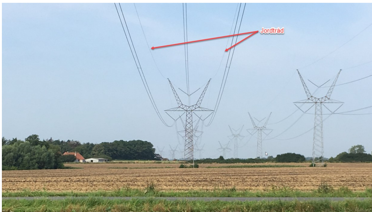
Figur 4-17 I midten af billedet mast nr. 79 set fra mast nr. 80. Jordtråden i toppen af masten er markeret med røde pile. Masterækken til højre er den nordlige luftledning fra 1990, som ikke er en del af projektet.
