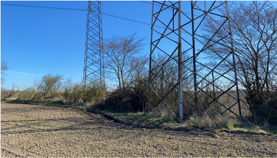
Figur 10-5 Jorddiget ved mast 88 set fra vest. Diget kan i praksis ikke erkendes før ca. 5 meter fra masten, hvor det er ca. 30 cm højt. Diget er mere tydeligt set fra øst.
