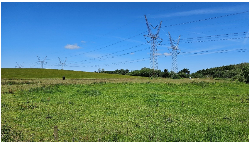
Figur 7-2 Mast 95 – den nærmeste mast, set fra sydøst og ind i den hesteafgræssede fold.
