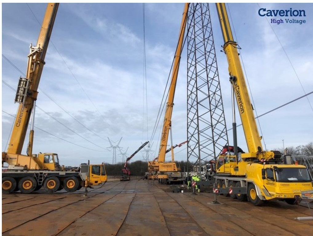
Figur 4-10 Eksempel på standard-arbejdsareal. Til venstre ses kranen der holder lederen oppe, forrest hovedkranen som løfter masten og bagerst kranen med lift.
