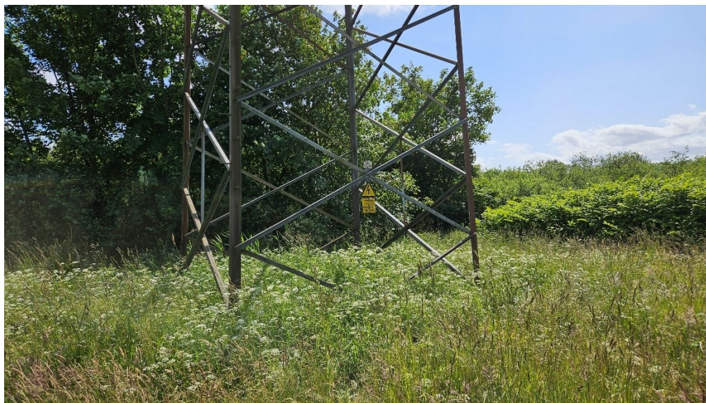
Figur 7-23 Mast 120 – Masten set fra nord. Til højre ses bevoksningen af japansk pileurt, i forgrunden vegetation hvor masten står, som er vejledende registreret som mose, men helt domineret af tørbundsarter som rød svingel, skvalderkål og fløjlsgræs.
