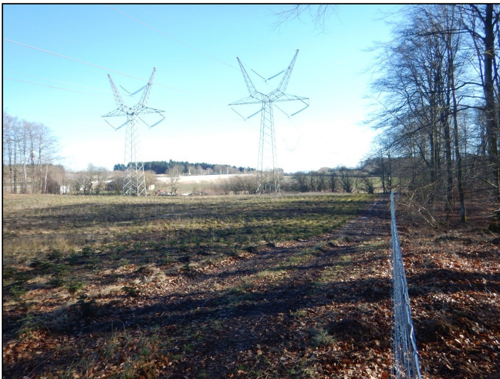
Figur 8-15 Arbejdsarealet ved mast 132 ligger i en meget ung juletræsplantage. Fra Swecos besigtigelse i februar og marts 2023.
