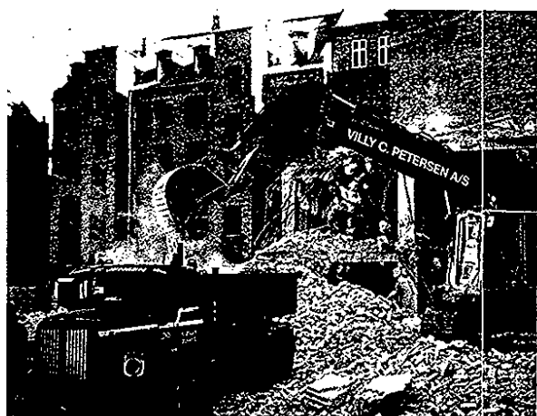
Figur 3.37 Læsning af brokker fra erhvervsbygning. I baggrunden tv. ses beboelsesejendom under nedrivning.
