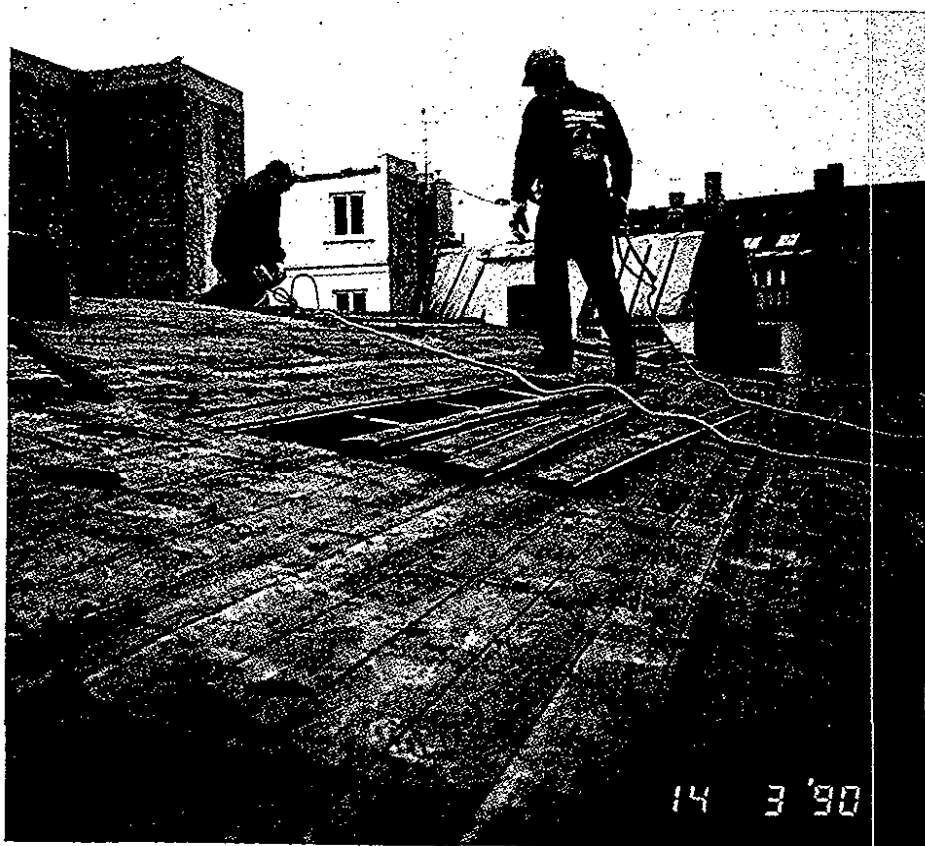
Figur 3.8 Optagning af brædder fra undertag.
