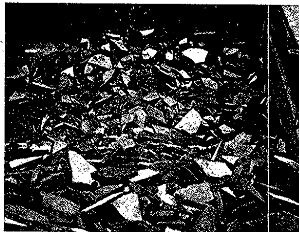
Figur 3.33 Asfaltbelægning fra erhvervsbygning. Opbrudt og lagt i container for restfraktion.
