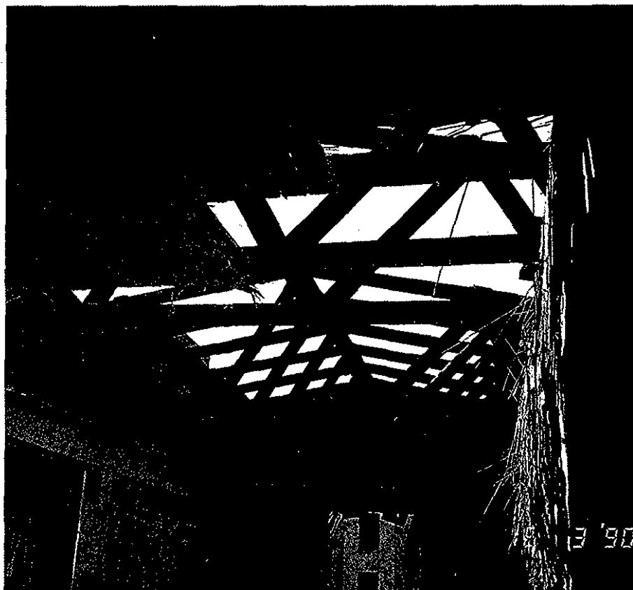
Figur 3.9 Gitterspær efter afgang af undertag og loftsforshalling.
