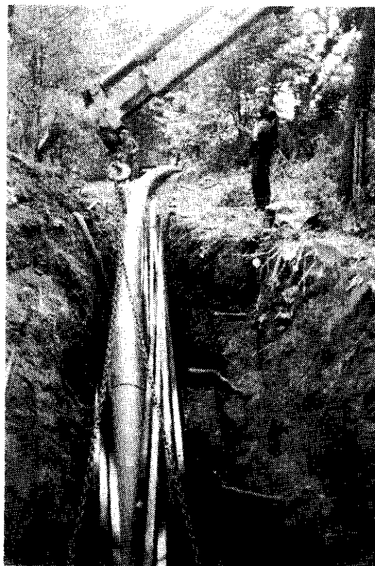
Figur 3.2 Indføringen kan ske gennem arbejdsgrube
