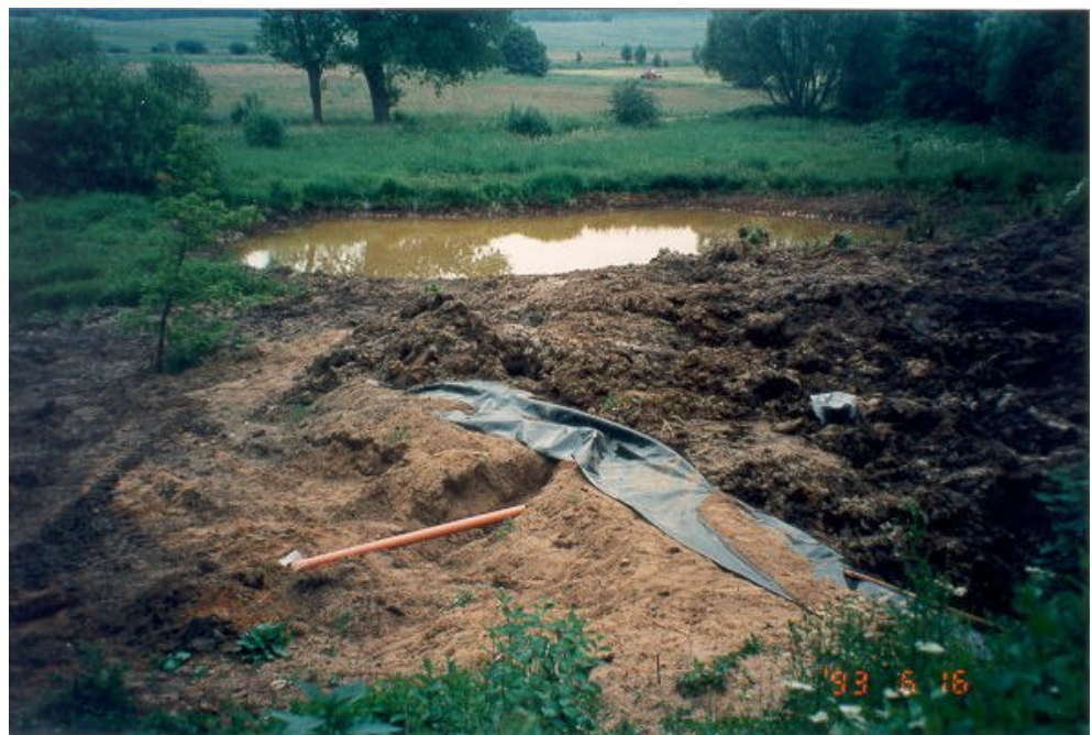
Figur 14.2: Anlæg 4 er etableret. Ved sammenligning med Figur 14.1 ses, at der er skabt en sø foran anlægget. Søen er dannet ved, at der er taget jord fra arealet til at fylde i anlægget.
