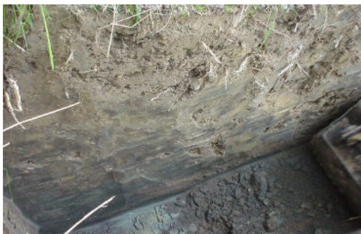
Figur 14.6 : Et typisk billede af svag rodsætning i pileanlæg. Billedet er fra et forholdsvis ler- og silt-holdigt anlæg. Det ses, at et anlæg i sådan en jordtype kan graves med relativt stejle sider, jævnfør Afsnit om hældningens betydning for nødvendigt overfladeareal og nødvendig anlægsvolumen.
