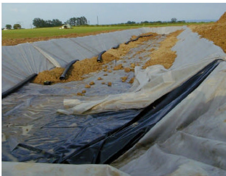
Figur 14.4: Membraner og fiberdug lagt i udgravning før tildækning med jord.
