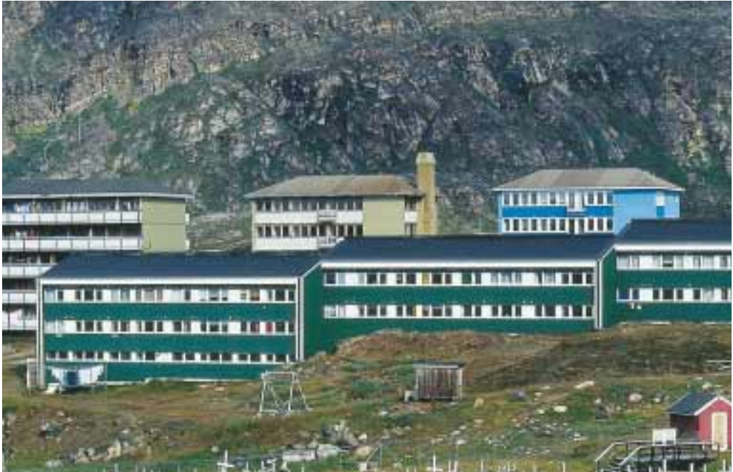
BOLIGBLOK FØR RENOVERING. FOTO: MADIS FÆGTEBORG
