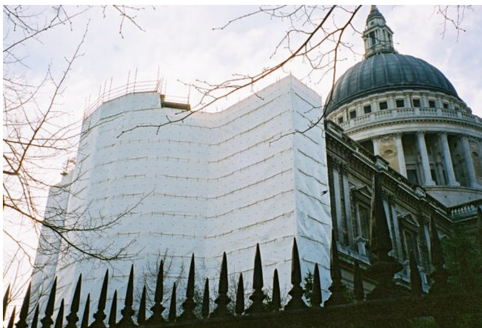
IPMs Flamesafe stilladspresenninger anvendes ved renovering af historiske bygninger, her St. Pauls Cathedral i London.
