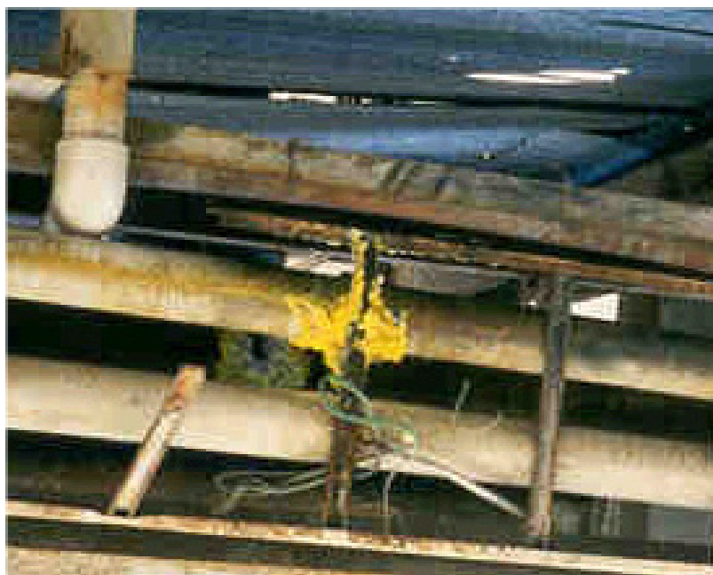
Figur A.3 Mindre læk af syre fra en flange
