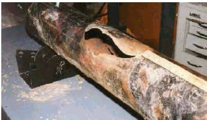
Figur A.2 Fiskemundsåbning pga. væskehammer i et propanrør
